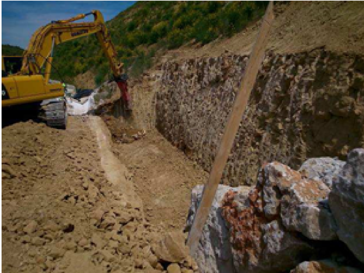
Detalle de la excavación de la cimentación de la escollera en la que tuvo que usarse el martillo hidráulico debido a la dureza de los materiales.
