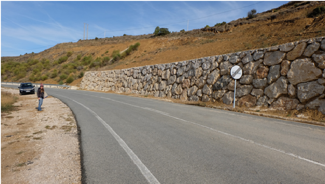
Escollera localizada al pie de la zona deslizada.
