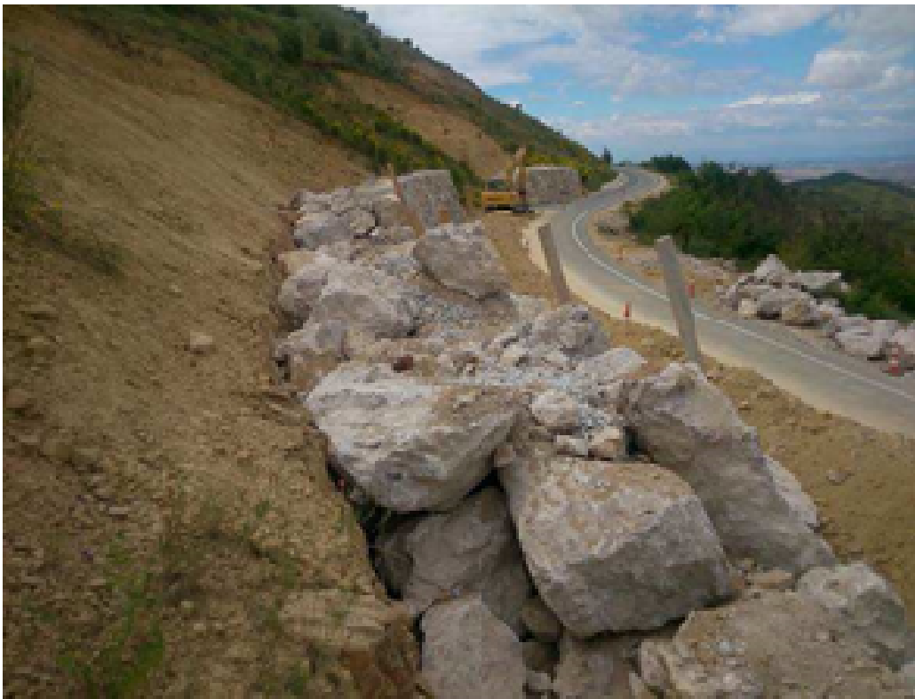
Fotografía del pie del talud tomada el 9/6/2016 durante la construcción de la escollera que actualmente refuerza el pie del talud.
