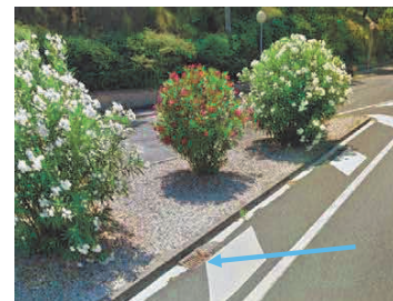
S1. Sumidero en calzada: retranqueo a nueva alineación.
