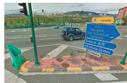
Isleta A-12 - A-15 (marg.dcha). Cambiar tapa (3 sanean/pluviales). Calzada (junto a isleta). Cambiar tapa (1 abastecimiento)
