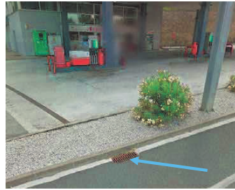
S4. Sumidero en calzada: retranqueo a nueva alineación.
