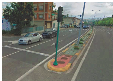
A. Aróstegui (Mediana). Las tapas se sustituyen y se colocan a cota de la nueva rasante del hormigón en el interior de la mediana.
