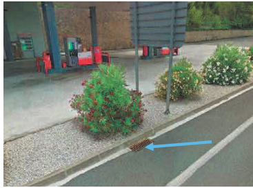
S3. Sumidero en calzada: retranqueo a nueva alineación.
