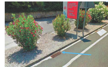
S2. Sumidero en calzada: retranqueo a nueva alineación.
