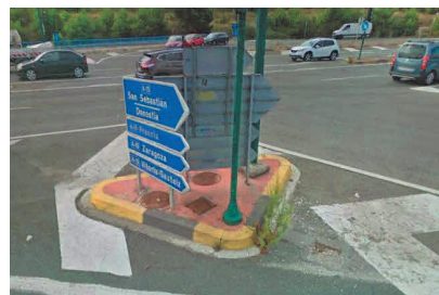
Isleta Avenida Aróstegui-A-15 (marg.izquierda). Las tapas se sustituyen y se colocan a la cota de la rasante de la calzada.
