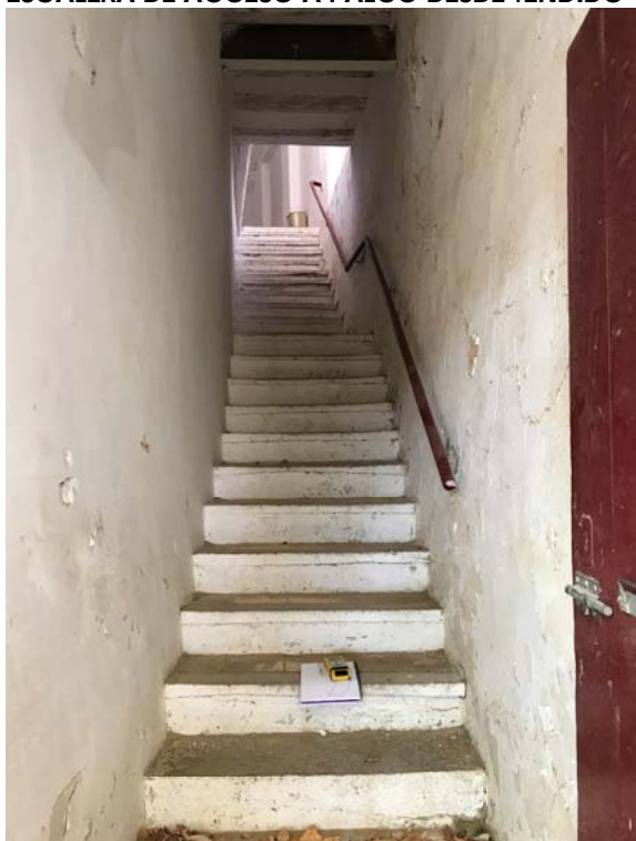
ESCALERA DE ACCESO A PALCO DESDE TENDIDO 4
