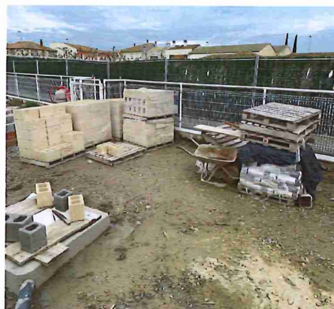
MATERIALES PARA LA OBRA
