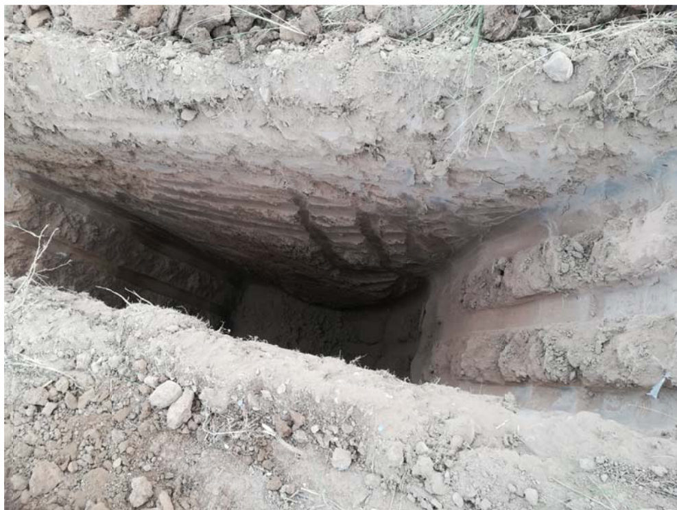
Fotografía nº9 – Perfil del terreno en calicata C-2.
