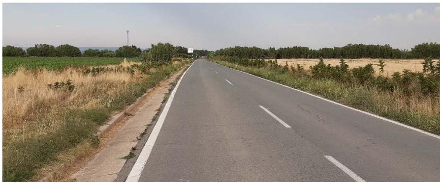
Lo que se proyecta es ensanchar la plataforma hasta los 8 m, para conseguir una calzada con dos carriles de 3,50 m. y sus respectivos arcenes exteriores de 0,50 m para mejorar la seguridad vial y la circulación del tráfico pesado.
