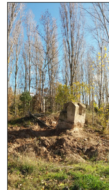
SOPORTE DE ANCLAJES CABLEADO ANTIGUA BARCA
