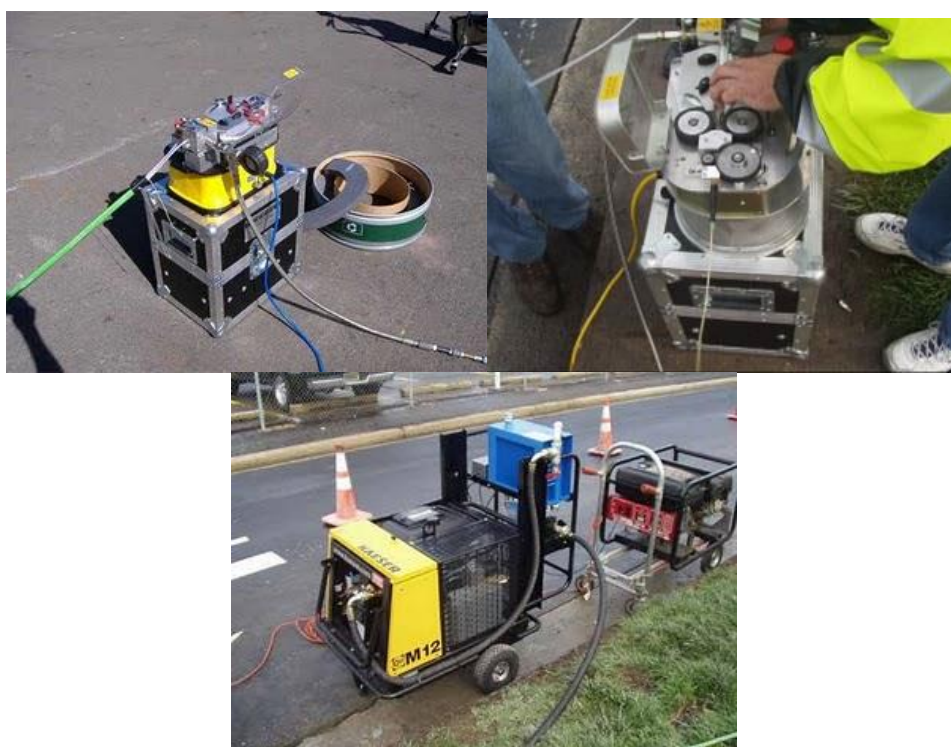
Figura 18. Proceso de soplado de la fibra óptica.
