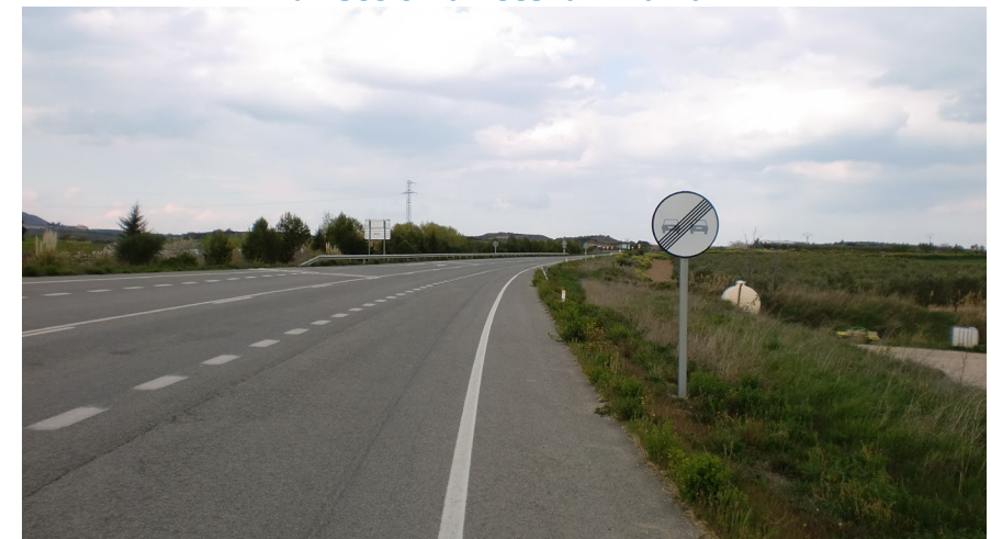
FOTO 18: Vista desde las proximidades de la glorieta del Pk 11+340 en dirección a Estella-Lizarra.
