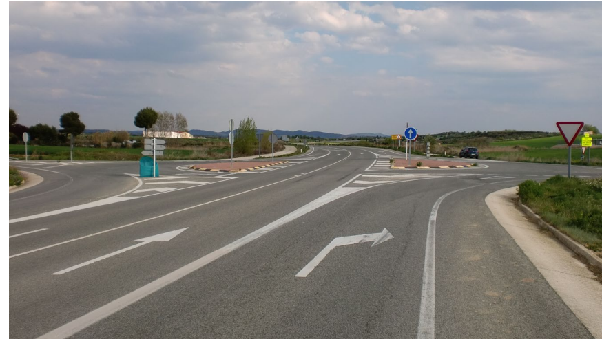
FOTO 11: Vista en dirección a glorieta en el Pk 12+260.
