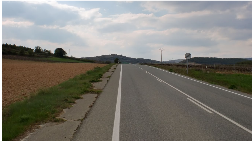
FOTO 1: Vista sentido Arroniz. Proximidades comienzo actuación en ctra. NA-6340.
