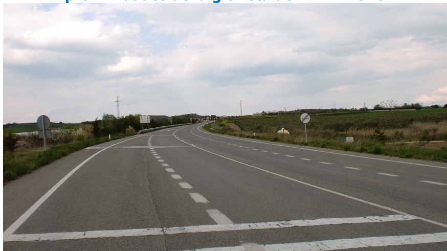
FOTO 16: Vista desde las proximidades de la glorieta del Pk 11+340 en dirección a Estella-Lizarra.
