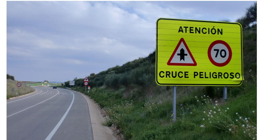
FOTO 15: Vista en dirección a glorieta en el Pk 12+260.
