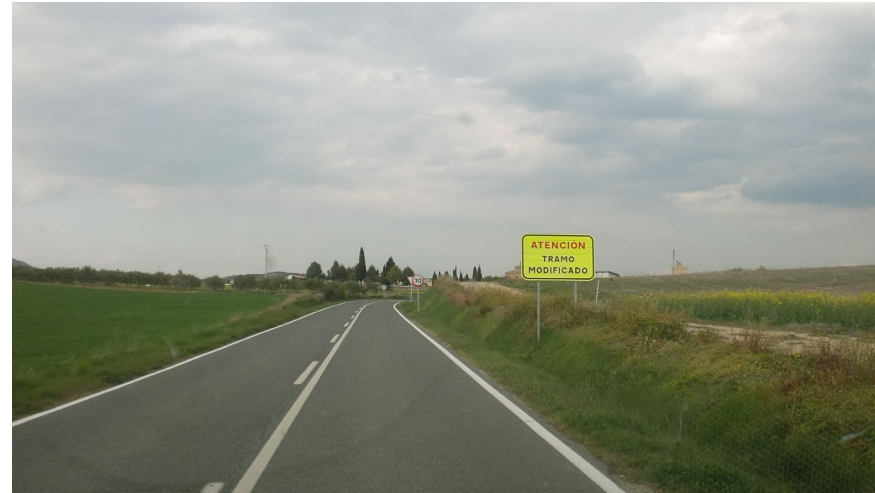
FOTO 2: Vista sentido Allo. Proximidades comienzo actuación en ctra. NA-666.
