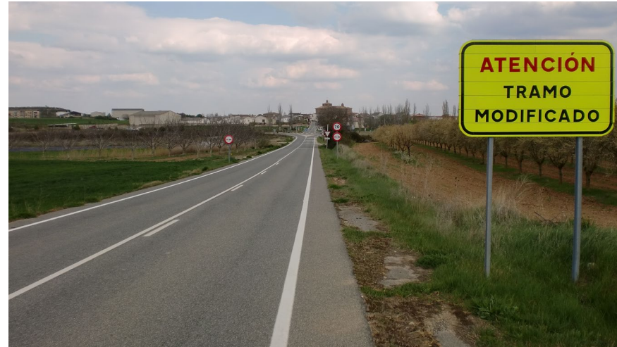
FOTO 2: Vista sentido Allo. Proximidades comienzo actuación en ctra. NA-6340.
