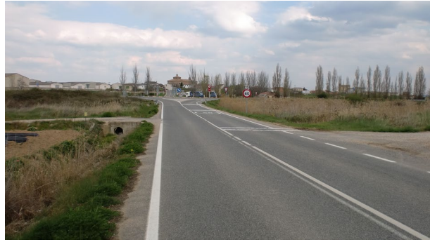
Ctra NA-6340 en las inmediac. de la intersección
