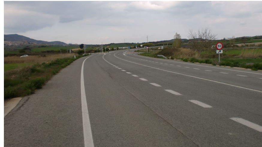
FOTO 14: Vista en dirección a Estella-Lizarra en las proximidades de la glorieta del Pk 11+340.
