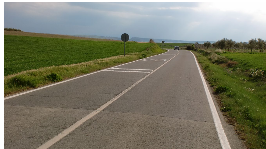
FOTO 8: Vista desde la glorieta del Pk 12+260 en dirección a Sesma y Lodosa.
