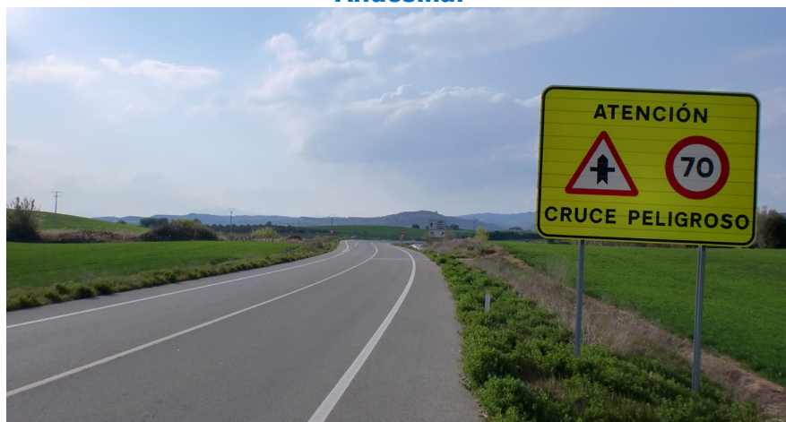
FOTO 25: Vista desde la NA-122 en dirección glorieta del Pk 12+260.
