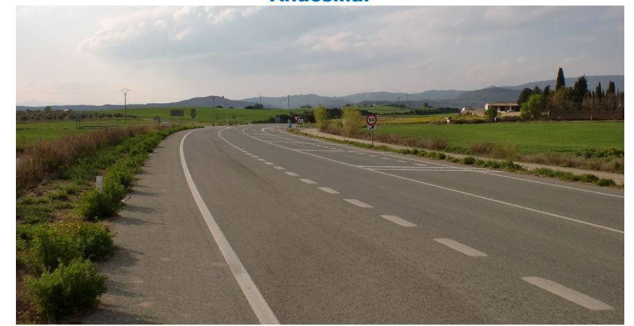
FOTO 27: Vista desde la NA-122 en dirección glorieta del Pk 12+260.
