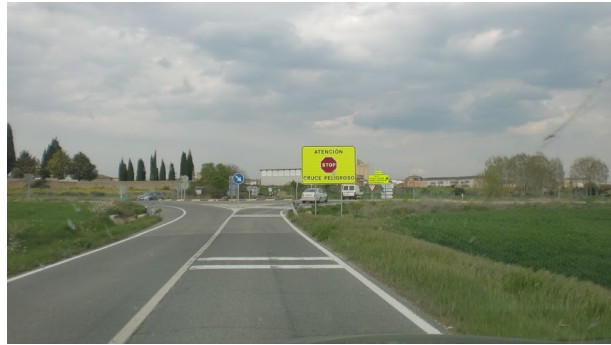
Ctra NA-666 en las inmediac. de la intersección
