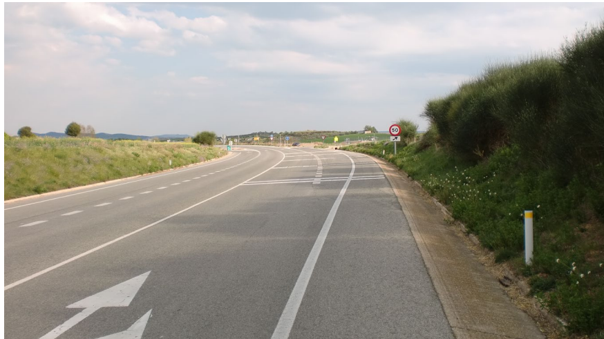
FOTO 13: Vista en dirección a glorieta en el Pk 12+260.
