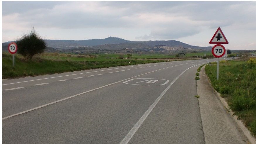
FOTO 13: Vista en dirección a Estella-Lizarra, en las proximidades de la glorieta del Pk 11+340.
