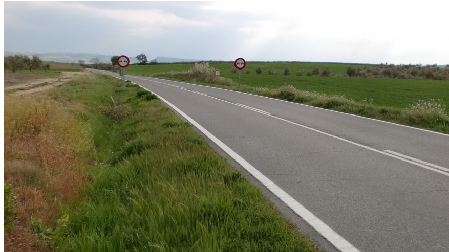
FOTO 1: Vista sentido Sesma y Lodosa. Proximidades comienzo actuación en ctra. NA-666.
