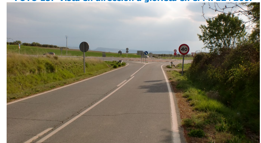
FOTO 18: Vista en dirección a la glorieta del Pk 12+260 procedente de Allo.
