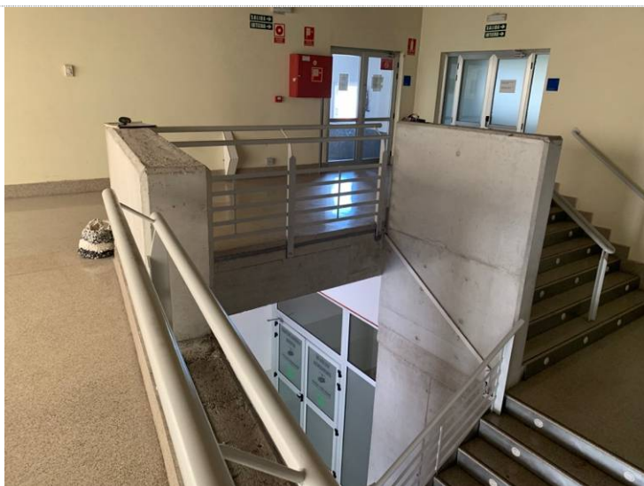
Vista desde el vestíbulo de la planta primera
