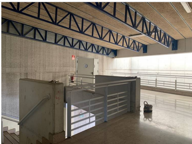
Vestíbulo planta primera
