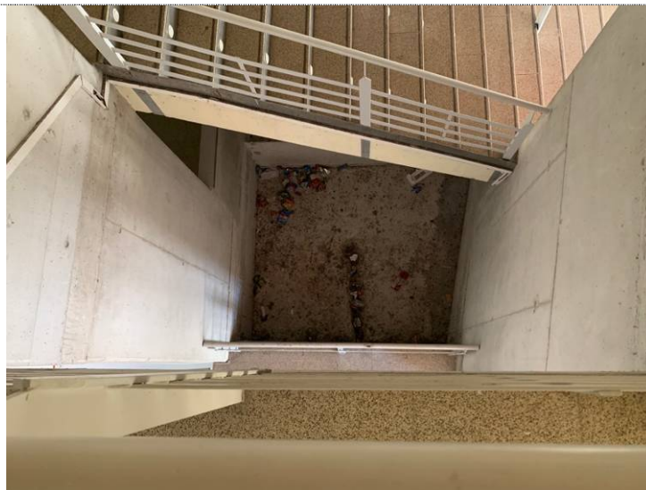
Vista del hueco existente desde la planta primera
