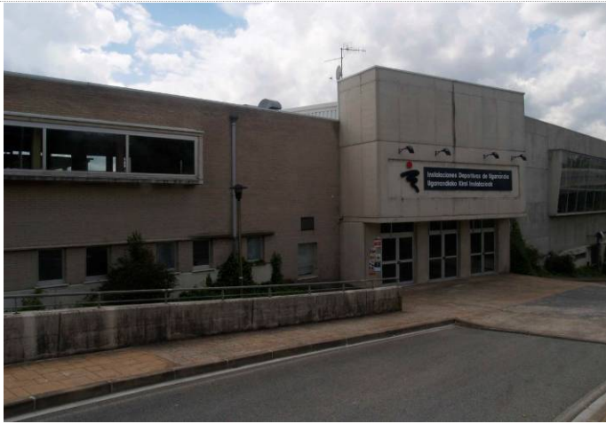
Vista exterior del edificio. Fachada Norte
