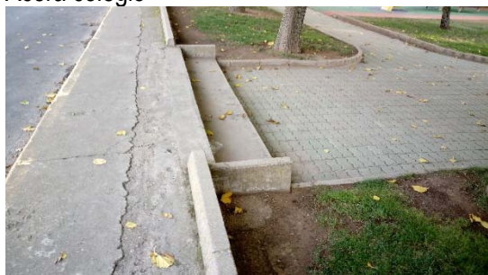
Escaleras lado colegio
