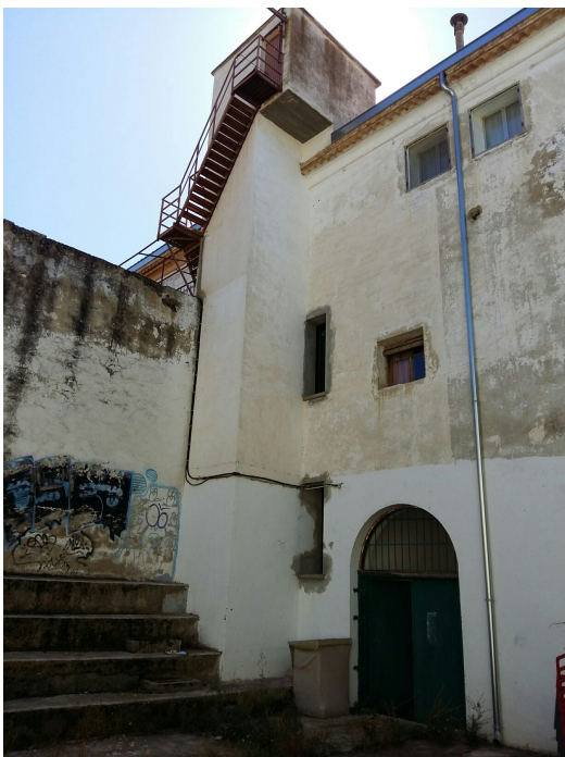
VISTA ASCENSOR ACTUAL
