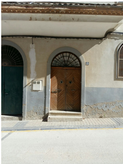
ACCESO A REFORMAR
