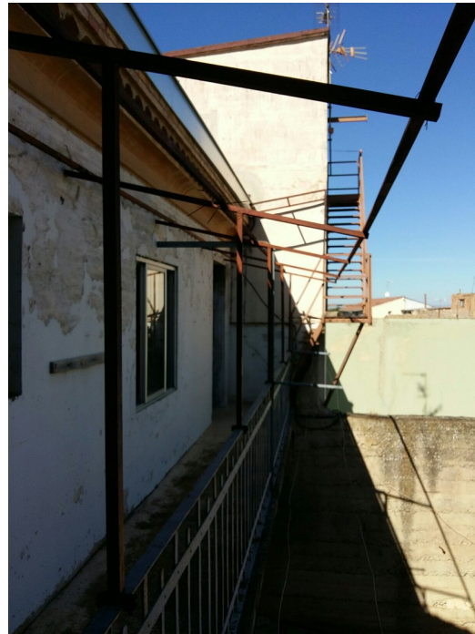
ACCESO A CUARTO ASCENSOR
