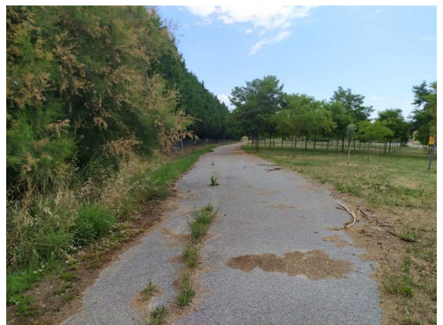
- camino de acceso pavimentado -
