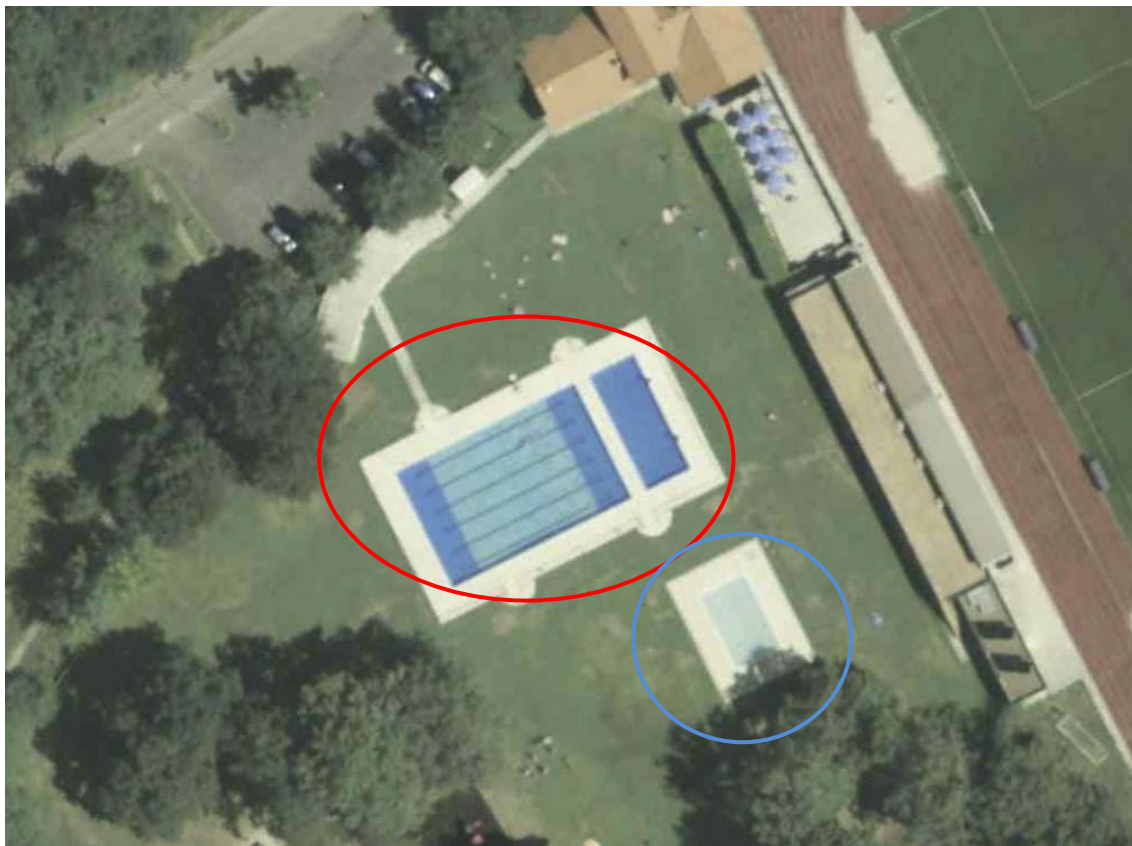
Piscinas en las Instalaciones Deportivas Dantzaleku.
