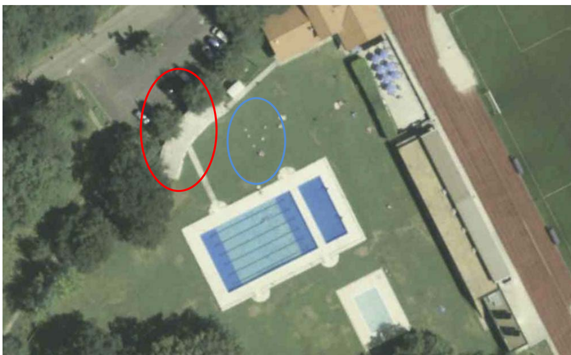
Piscinas en las Instalaciones Deportivas Dantzaleku.
