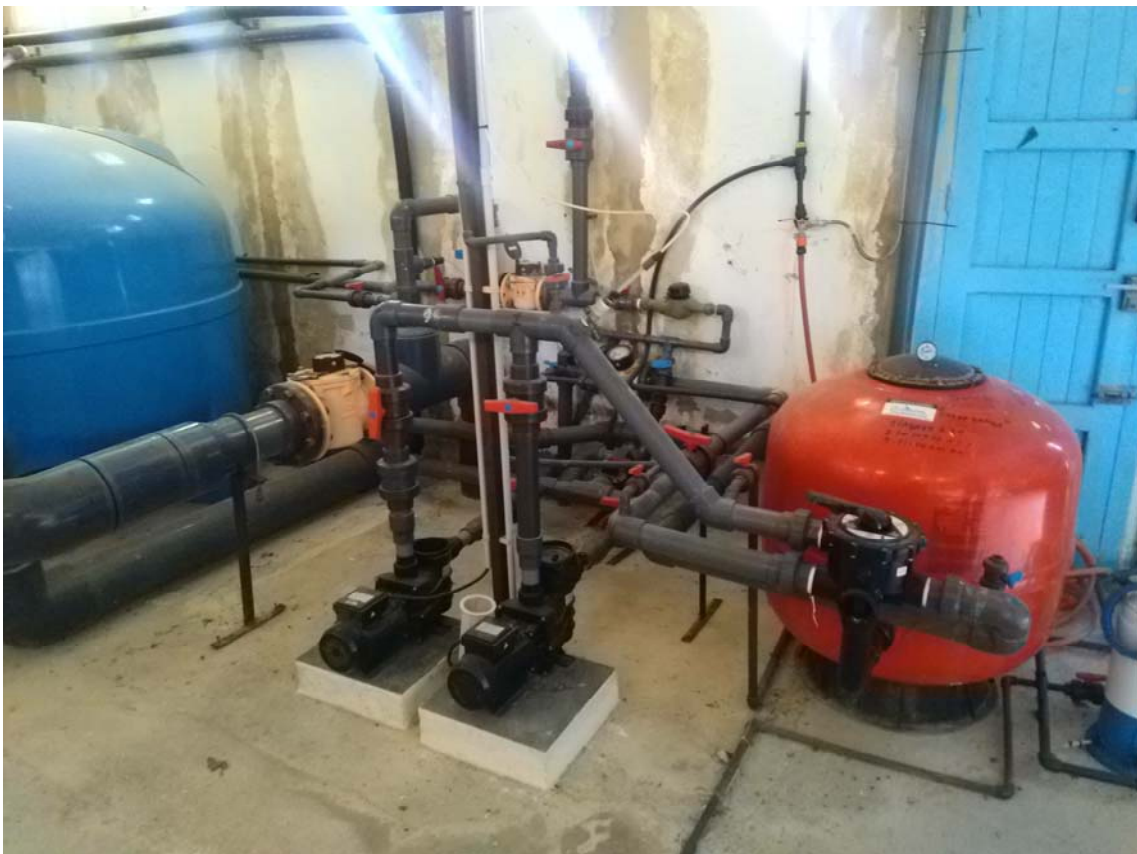
Bombeo y depuración de la piscina de chapoteo.
