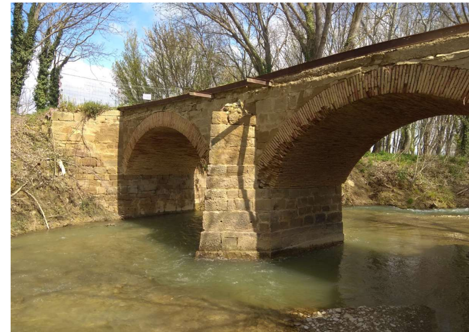
Figura 2 - Restos de la estructura metálica para paso de peatones. Vista desde el río
