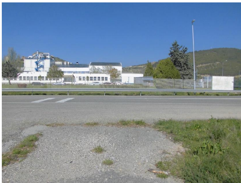
Fotografía del punto peligroso por atravesar el sendero la carretera
