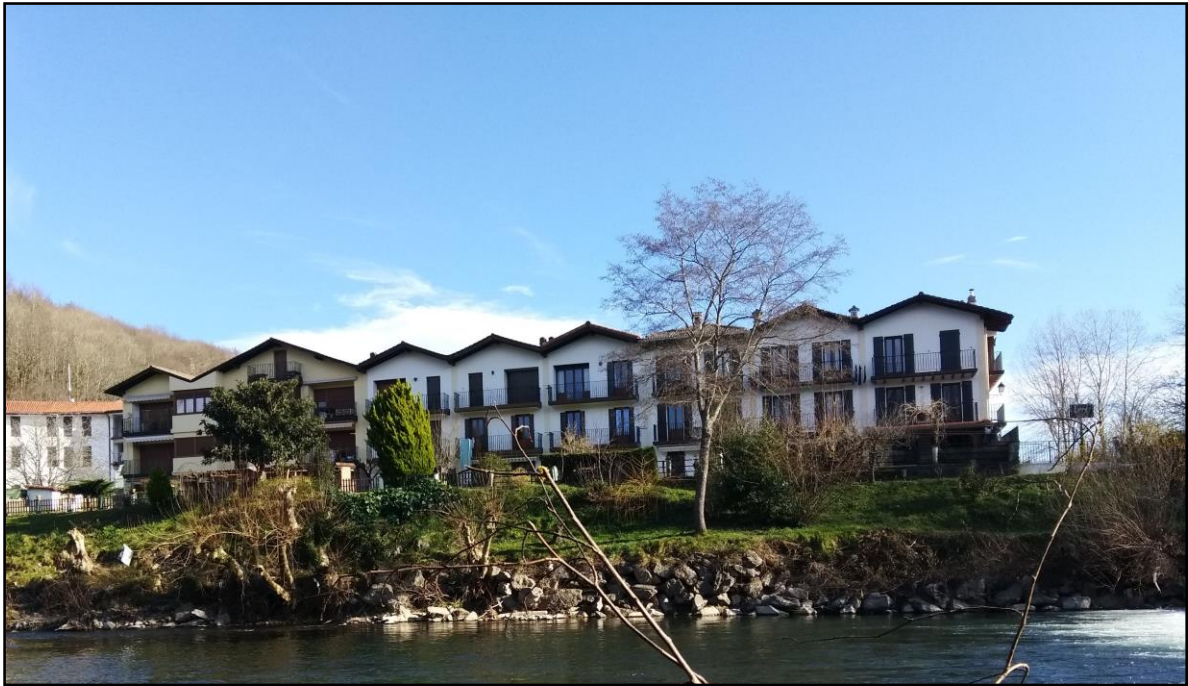
Estado actual de la escollera existente
