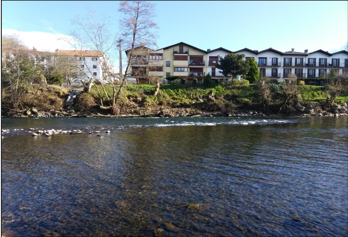
Imagen estado actual de la protección deteriorada en margen derecha del río Bidasoa
