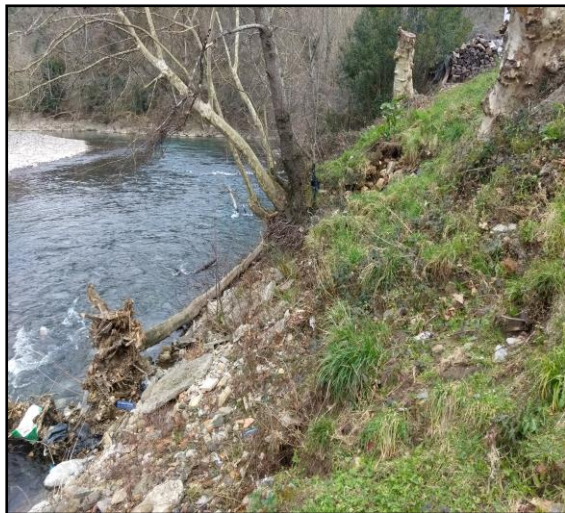
Deslizamientos del talud de la margen derecha.
