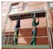
3°. Colocación de plataformas con o sin trampilla y escalera para acceso rápido y seguro
