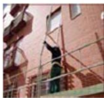
1°. Montaje del módulo vertical con el pórtico
