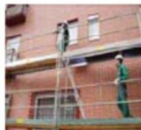
4°. Subida al nivel superior con la protección instalada
