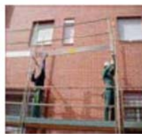
2°. Montaje de la barandilla de protección con rodapié incluido
