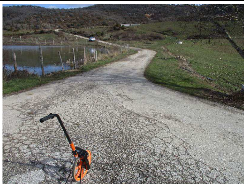
Entronque con carretera Na-7059, Pk 0,00
