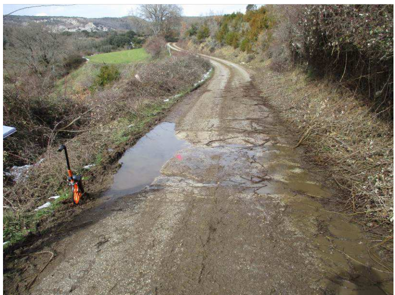
Punto a colocar tubo drenaje de 600 mm
