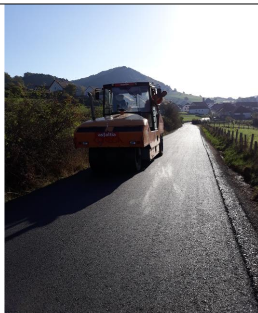
Compactación del pavimento
