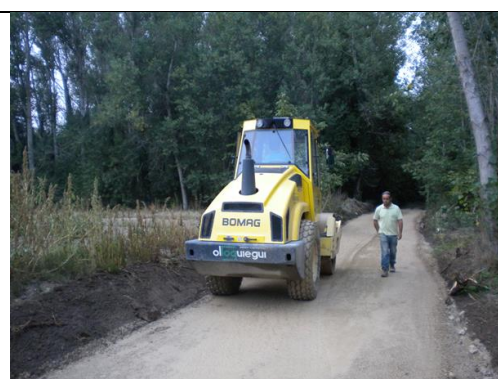
Tipo de vibrocompactador a emplear para compactar la rasante
