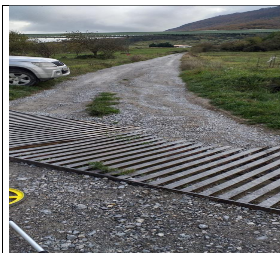
Rejilla a demoler
