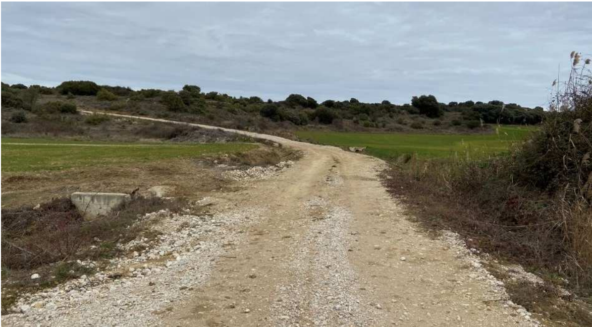
Ilustración 41. Ejemplo representativo del tramo 3 de la Pista 7.
