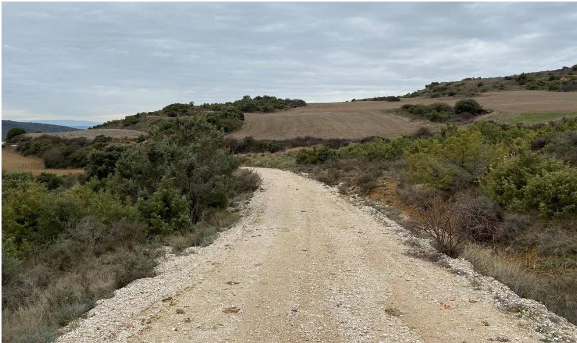
Ilustración 33. Ejemplo del estado en el que se encuentran los tramos 1, 2, 3 y 4 de la Pista 6. Se ha lavado el material granular de la plataforma de la pista y se ha depositado en la cuneta y en el talud del terraplén.
