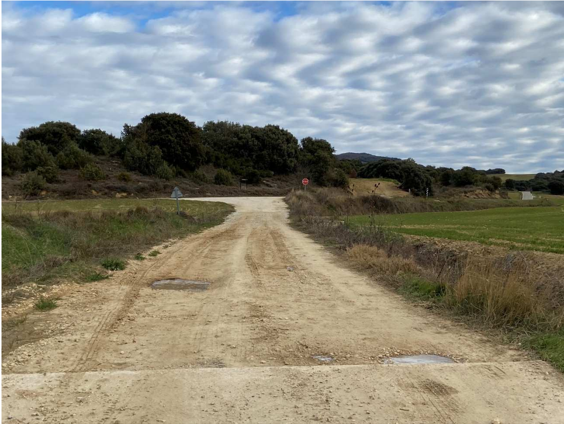
Ilustración 14. Situación actual del tramo 1 de la Pista 3.
