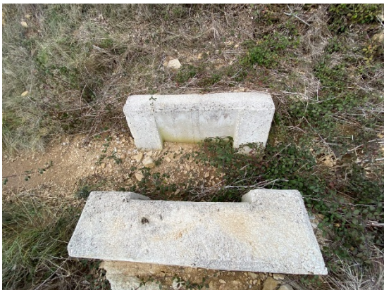
Ilustración 7. Detalle de caño totalmente aterrado. (Actuación Puntual 3).
