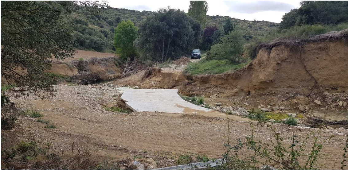
Ilustración 46. Tramos 1 y 2 de la Pista 8 y punto en que se va a construir el paso sobre el cauce para dar acceso a parcelas agrícolas (Actuación puntual 11) (Foto tomada desde la margen izquierda del río).
