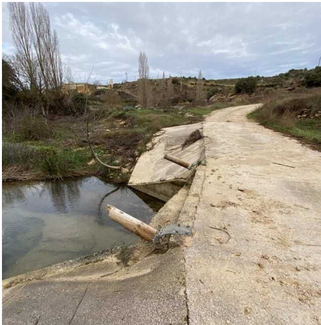
Ilustración 10. Barandilla de seguridad en paso sobre cauce que es necesario restituir. (Actuación puntual 4)
