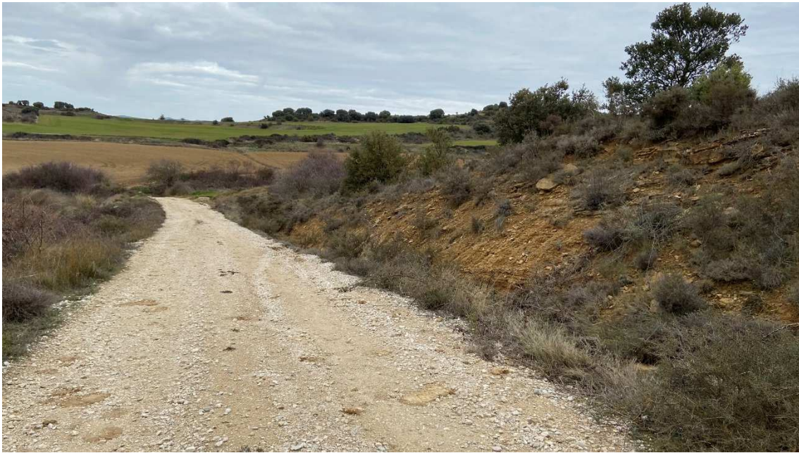
Ilustración 36. Estado de los tramos 5 y 6 de la Pista 6.
