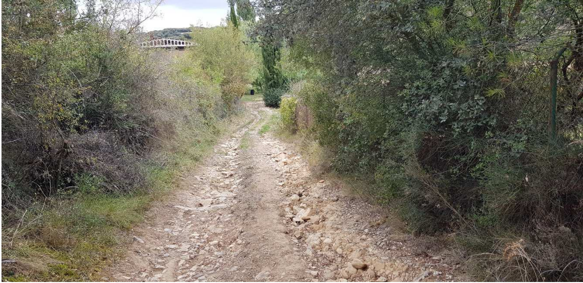
Ilustración 48. Estado actual del tramo 3 de la Pista 8 en el que se plantea el aporte de 20 cm de material.
