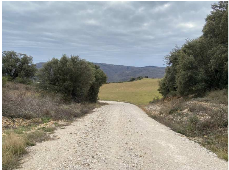
Ilustración 21. Situación actual del tramo 7 de la Pista 3.
