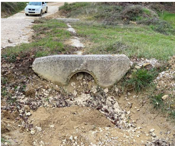
Ilustración 4. Ejemplos de la situación actual de los tubos que son objeto de trabajos de limpieza.
