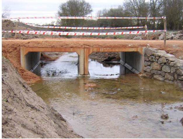
Ilustración 8. Ejemplo de obra de paso construida por 2 módulos prefabricados.
