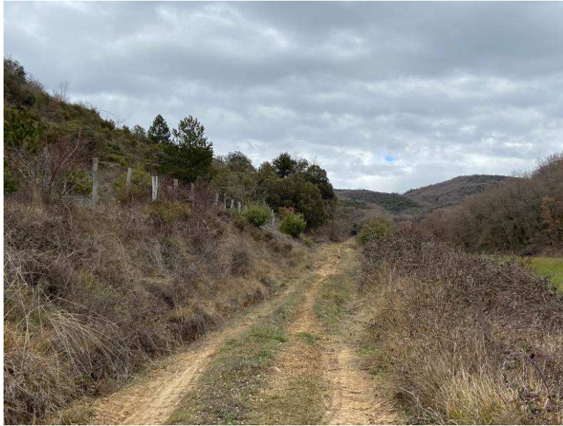
Ilustración 3. Tramo de pista en tierra, en la que se pueden apreciar los daños causados por el arrastre de materiales.
