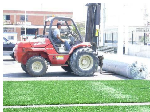
Figura 2: Colocación del rollo para comenzar a extenderlo en sentido transversal
