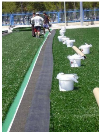
Figuras 19 y 20: Pegado de los rollos sobre la cinta geotextil, manteniendo una distancia de separación en la junta, similar a la galga del tufting. (comprobación visual de la anchura de la junta)
