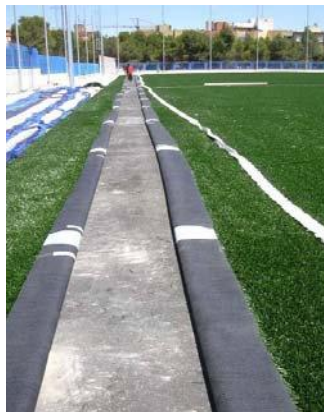
Figura 22 Hueco abierto en el césped para la colocación, del marcaje correspondiente a la línea de meta.
