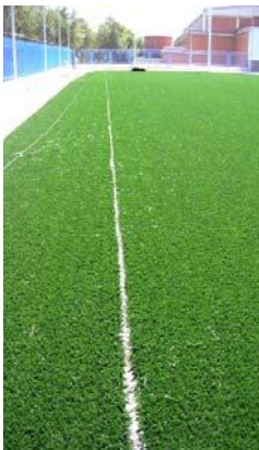
Figura 22 Hueco abierto en el césped para la colocación, del marcaje correspondiente a la línea de meta.
