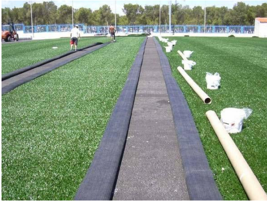
Figuras 12 y 13: Proceso de apertura de los rollos que van a ser unidos y comprobación de la ausencia de humedad.
