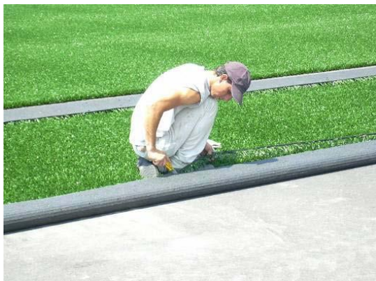
Figura 8: Saneado, para conseguir una distancia homogénea en la unión entre los rollos
