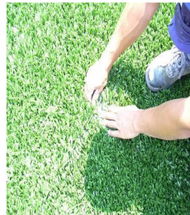
Figuras 19 y 20: Pegado de los rollos sobre la cinta geotextil, manteniendo una distancia de separación en la junta, similar a la galga del tufting. (comprobación visual de la anchura de la junta)
