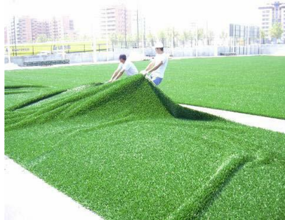
Figura 6: Ajuste final del rollo extendido teniendo especial cuidado en que no quede ninguna arruga
