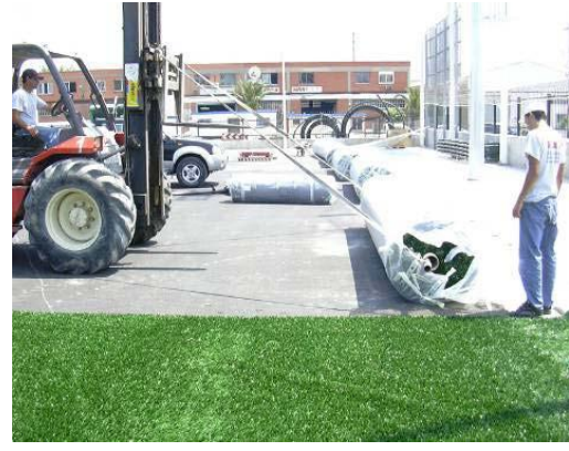
Figura 4: inicio de extendido del rollo de césped
