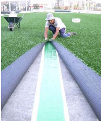
Figuras 19 y 20: Pegado de los rollos sobre la cinta geotextil, manteniendo una distancia de separación en la junta, similar a la galga del tufting. (comprobación visual de la anchura de la junta)
