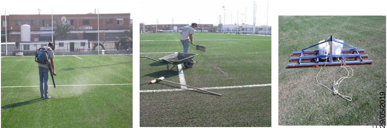
Figura 27: Detalle del soplado de las zonas chafadas y relleno y extendido manual de las zonas “chafadas”(Bateria de cepillos utilizada para dar el acabado al campo)
