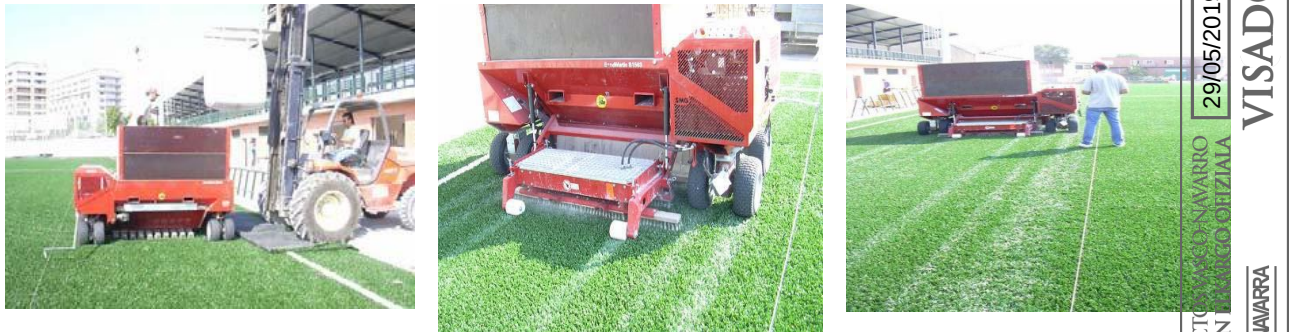
Figura 25: Máquina extendedora de arena (proceso de distribución de la arena)
