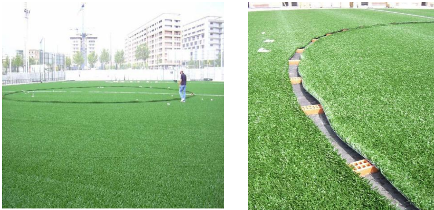
Figura 24: Círculo central cortado y preparado para la colocación de la línea de marcaje. (Detalle de la colocación de ladrillos bajo el césped, para la eliminación de humedad. Corte y marcaje de las líneas de áreas de esquina.)
