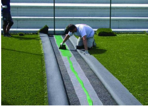
Figuras 17 y 18: Detalle del encolado de la cinta geotextil, con resina de poliuretano PU 300.
