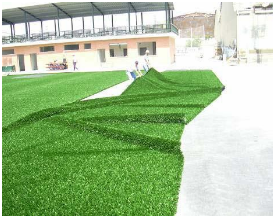
Figura 5: Ajuste manual al lateral del rollo anterior.
