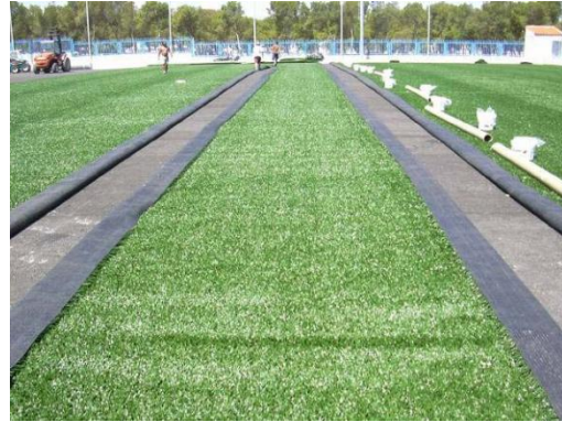
Figuras 12 y 13: Proceso de apertura de los rollos que van a ser unidos y comprobación de la ausencia de humedad.
