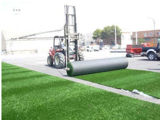
Figura 1: Detalle del extendido de los rollos en sentido transversal del campo
