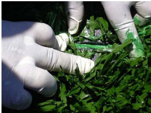
Figura 10: Detalle de la separación de la junta ajustándola a la canaleta
