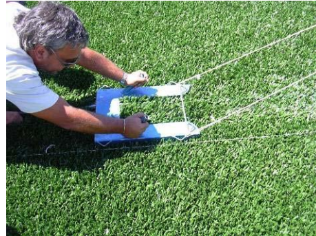
Figura 21: Herramienta utilizada para realizar el corte del césped, para colocar las líneas de marcaje.
