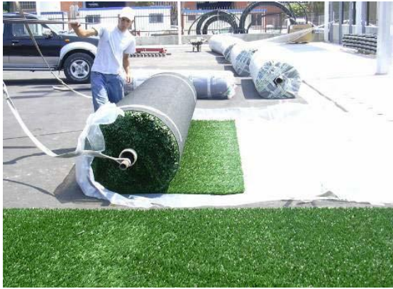
Figura 3: Detalle de la colocación de las eslingas para el extendido del rollo
