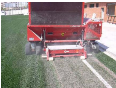
Figura 26: Máquina extendidora cargada con caucho y distribución del mismo.
