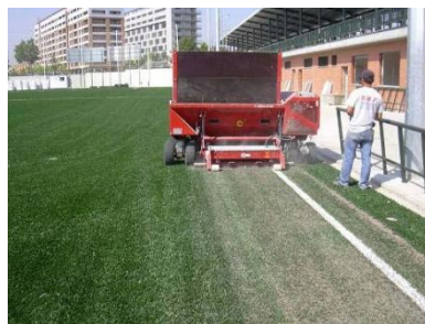
Figura 26: Máquina extendidora cargada con caucho y distribución del mismo.
