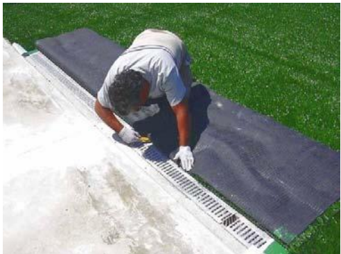
Figura 11: Recorte del extremo del rollo pegado, de unión entre rollos.
