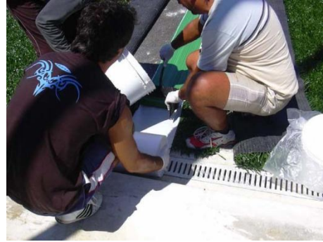
Figuras 17 y 18: Detalle del encolado de la cinta geotextil, con resina de poliuretano PU 300.
