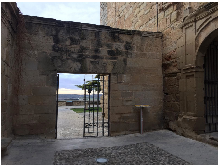
Imagen: Acceso principal
