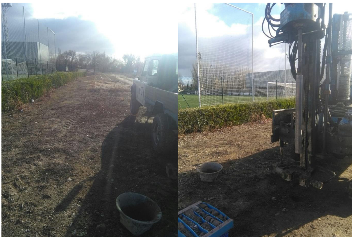
Vista de la parcela de estudio y situación del sondeo de reconocimiento.
