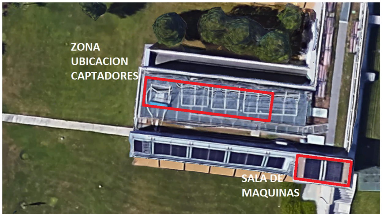
Figura 3 Fotografía aérea del emplazamiento y cubierta del edificio
