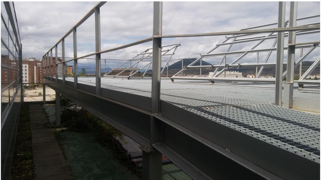
Figura 2 Estructura inferior soporte del Tramex de la zona de ensayo
