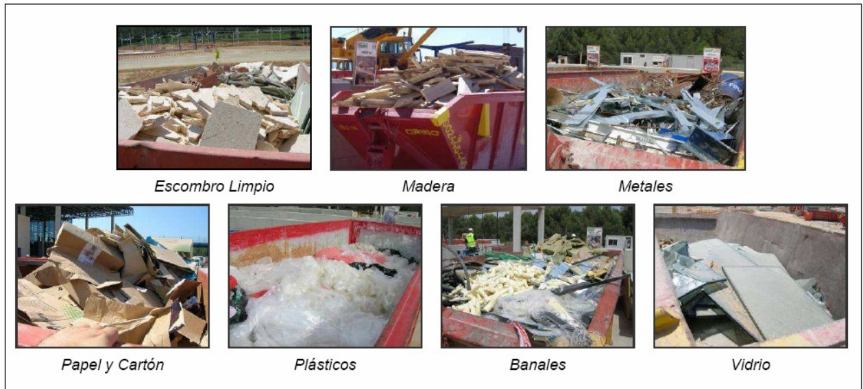
Imagen 1: Fracciones de RCD's separadas en obra
