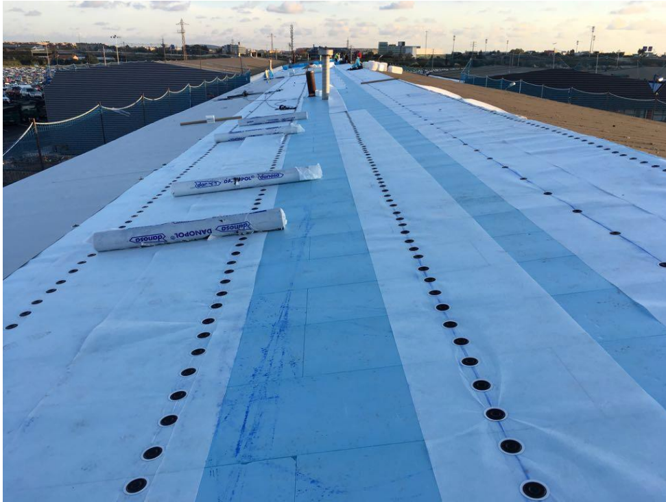
Imagen de la colocación de la lamina TPO en un instalación similar a la prevista
