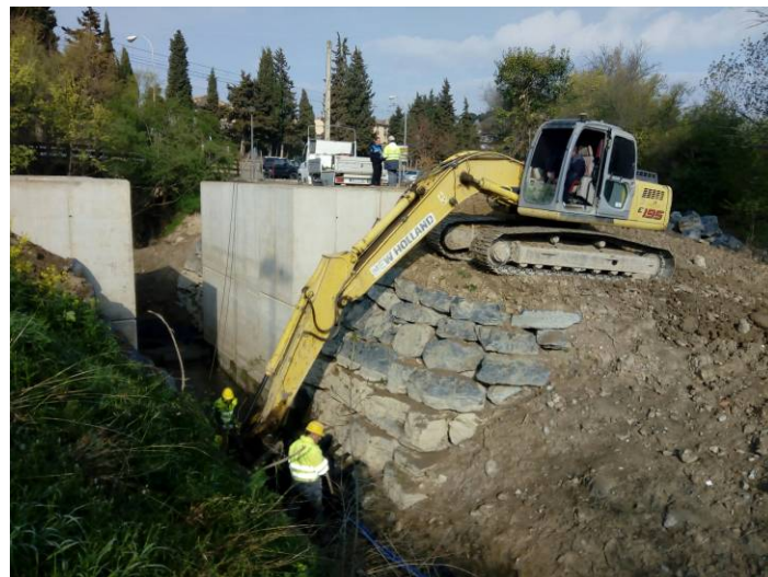
Fig.5.: Obras para colocación de compuerta en el cauce del Mediavilla. Fuente: CHE.
