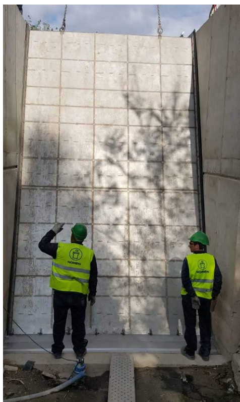
Fig.6.: Trabajos de colocación de compuerta en la desembocadura del barranco Mediavilla. Fuente: CHE
