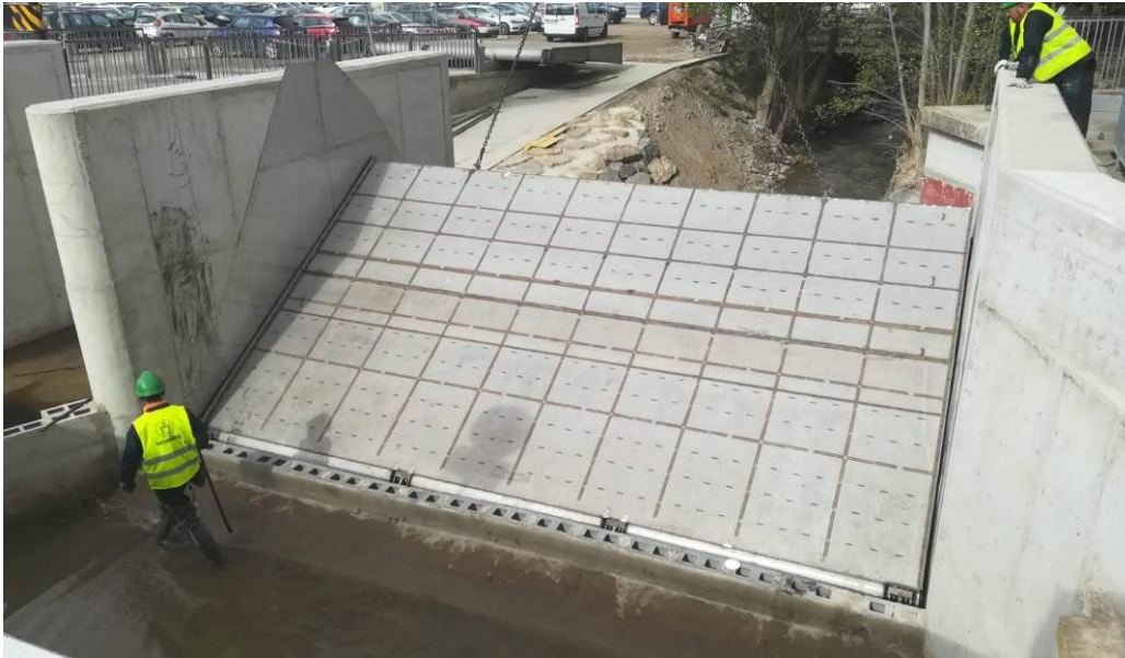
Fig.4.: Trabajos de colocación de una de las compuertas en la desembocadura del Queiles. Fuente: CHE
