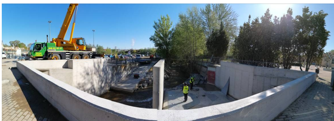
Fig.3.: Imagen de las obras en la desembocadura del Queiles antes de colocar las dos compuertas
