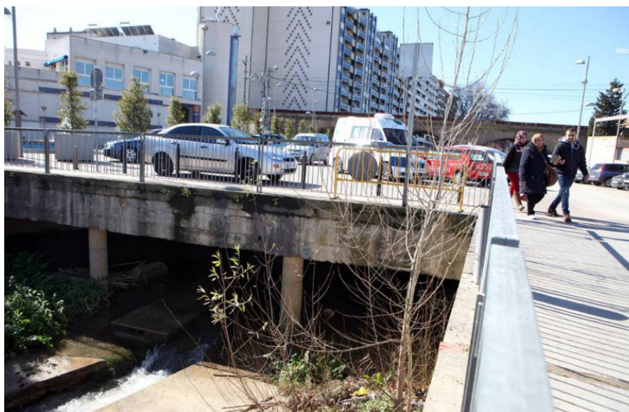
Fig.2.: Aspecto de la salida del soterramiento del río Queiles en Tudela, antes de la colocación de las compuertas.
