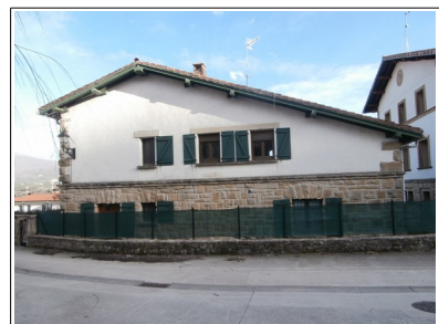
Frente posterior de la edificación
