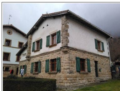
Frente norte del edificio
