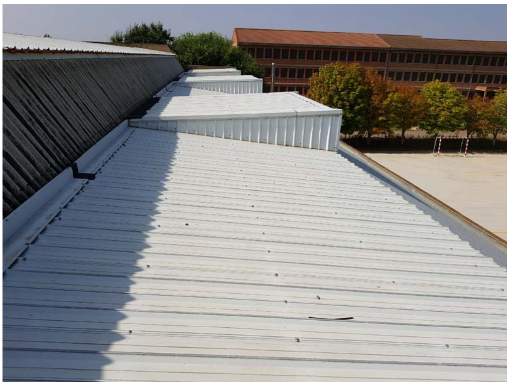
VISTA EXTERIOR - CUBIERTA
