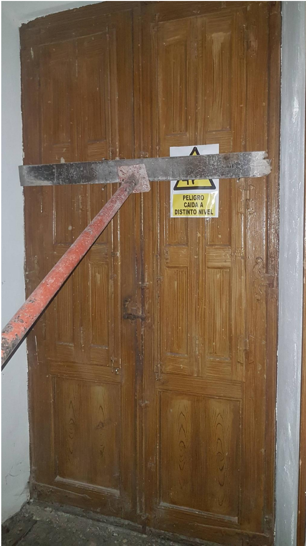
Entreplanta (E24b). Cierre de huecos y señalización de peligro
