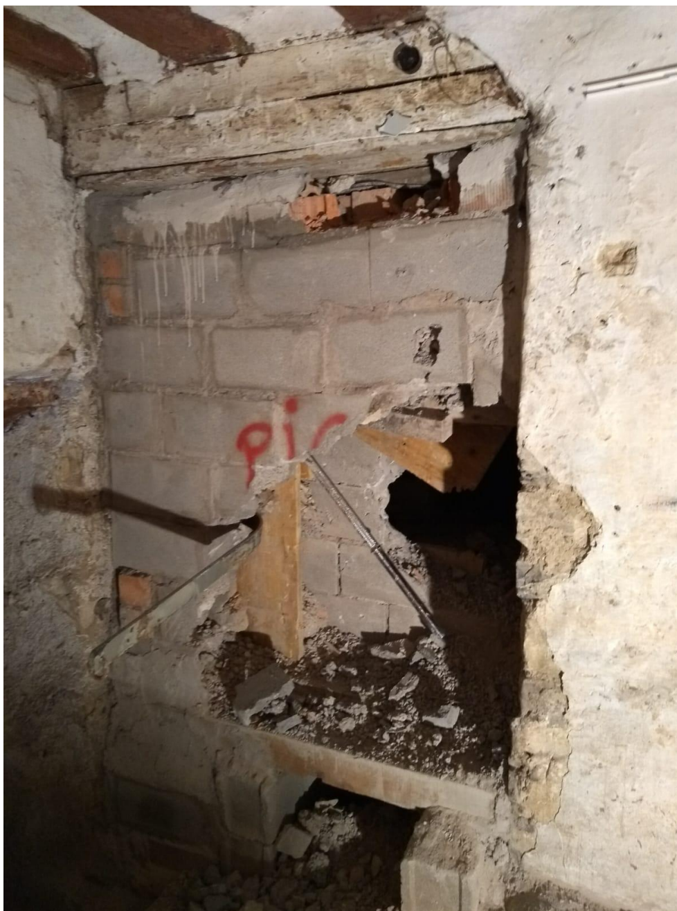
Planta baja (B07a). Cierre del hueco bajo la escalera con doble fábrica armada de bloque
