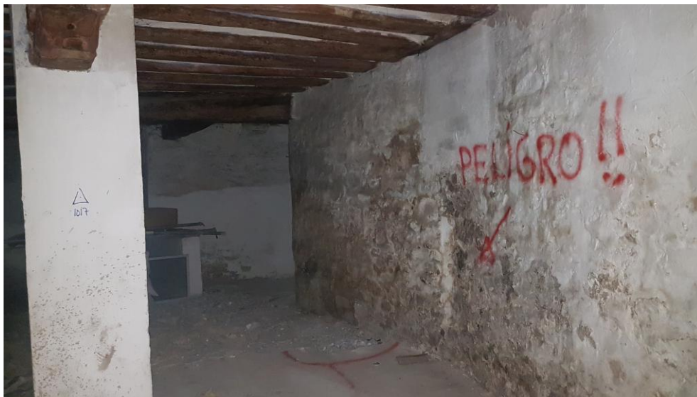
Planta baja (B12). Levante de capa de compresión y verificación del estado de la estructura
