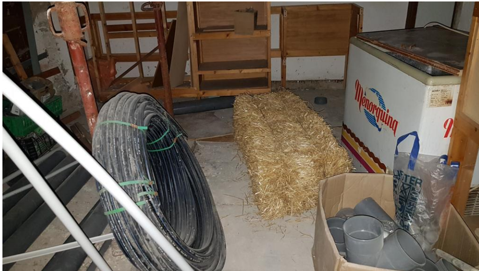
Entreplanta (E05a). Almacenaje de productos inflamables
