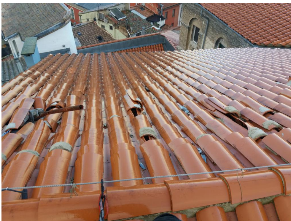
Cubierta superior (Este). Faldón hacia el patio interior
