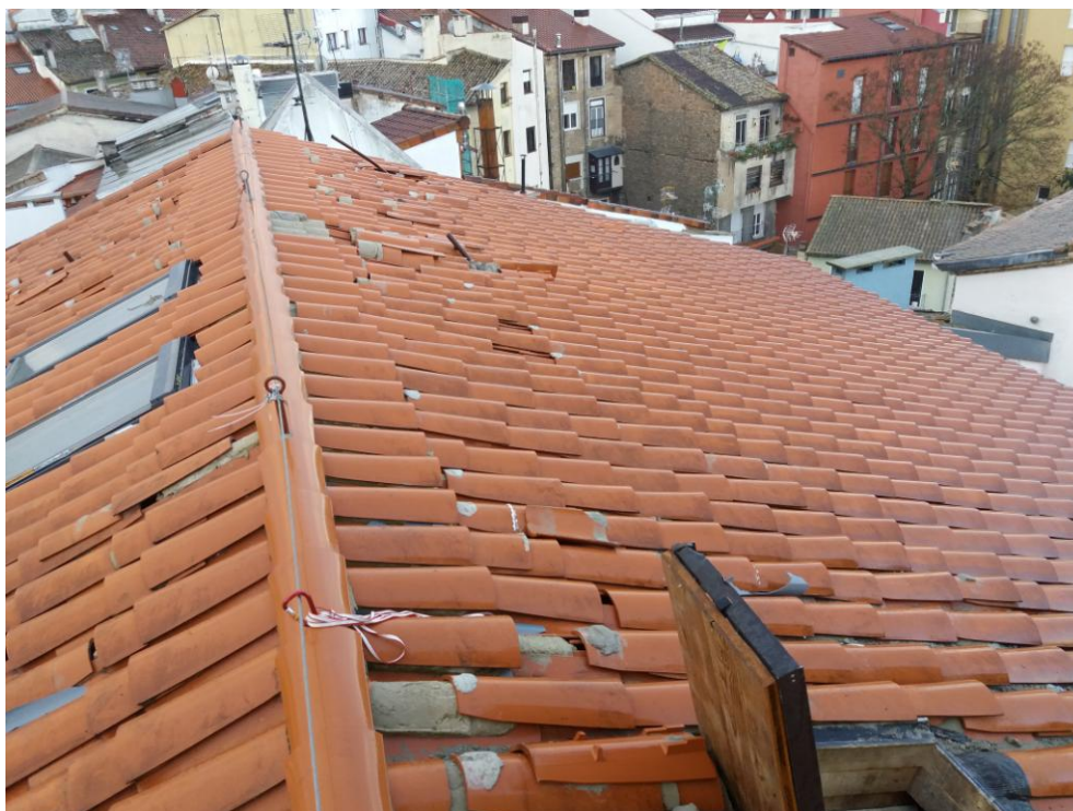
Cumbrera cubierta superior (Este)
