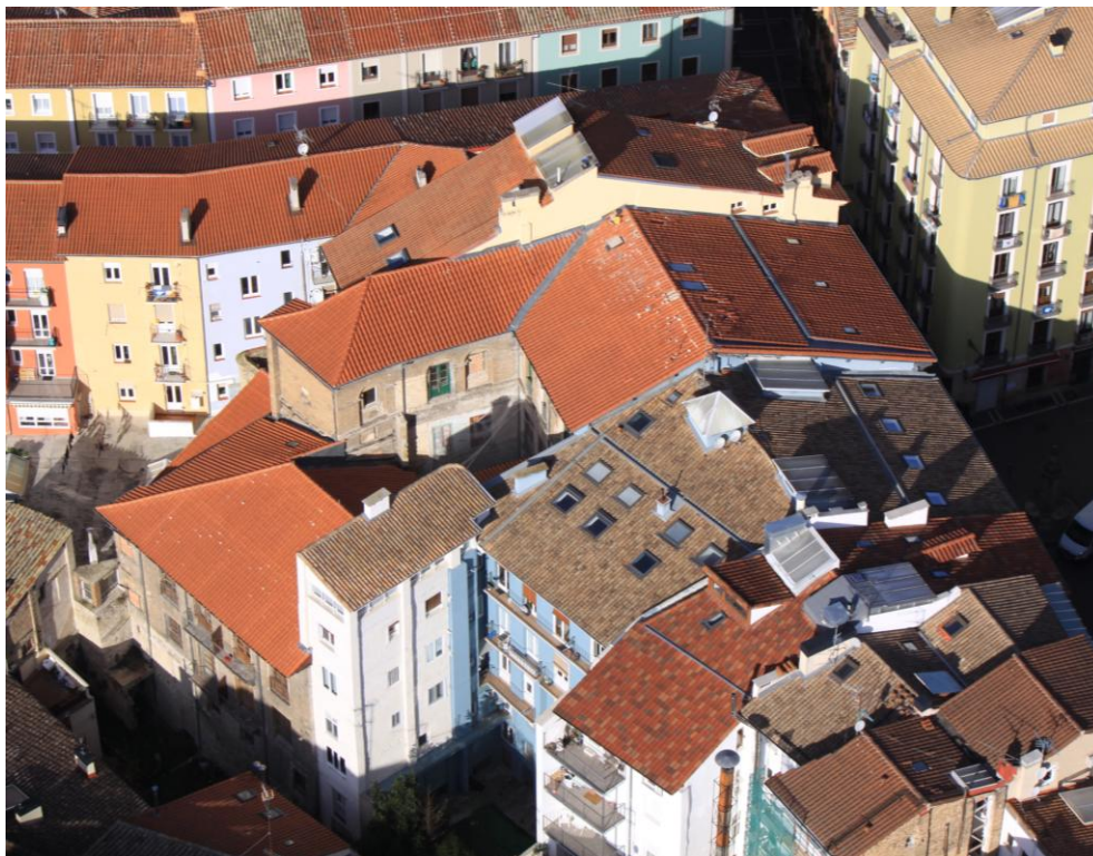
Cubiertas. Fotografía realizada desde el Sur
