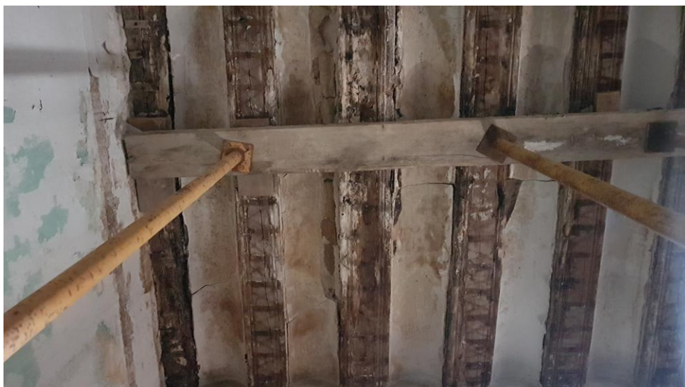
Planta primera (117a). Apeo de estructura de madera con pudrición
