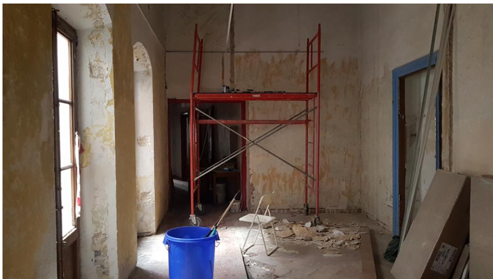
Planta primera (111a). Rascado y enlucido de paredes y ejecución de falso techo
