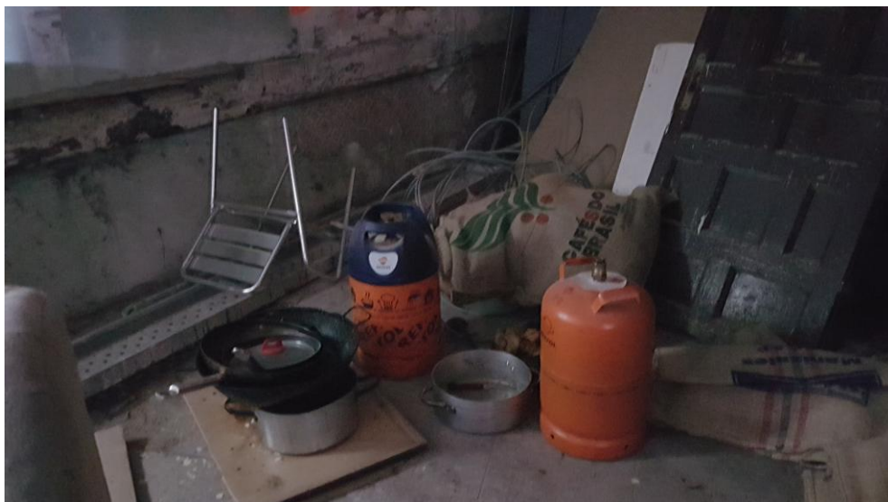
Planta segunda (201a). Bombonas y almacenaje de productos inflamables
