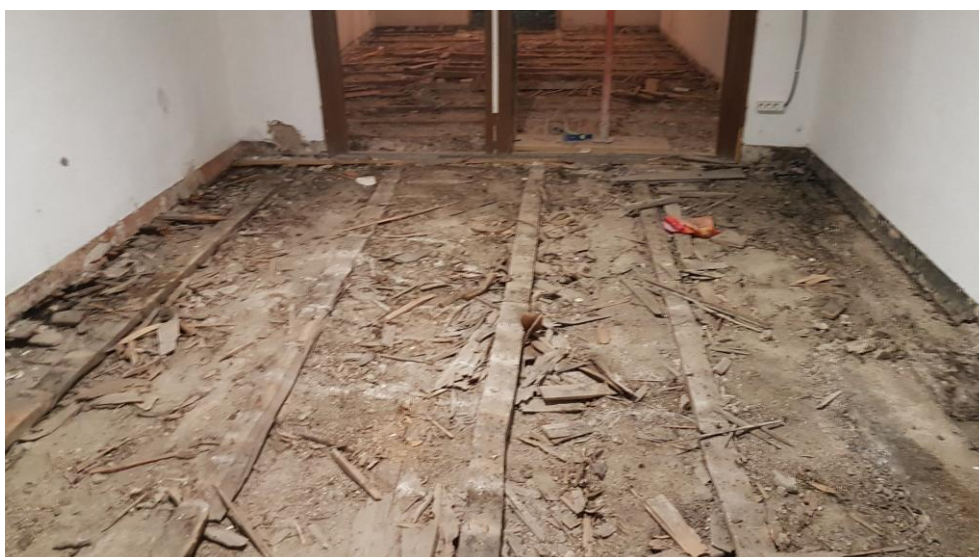
Planta primera (110e). Levante de pavimento
