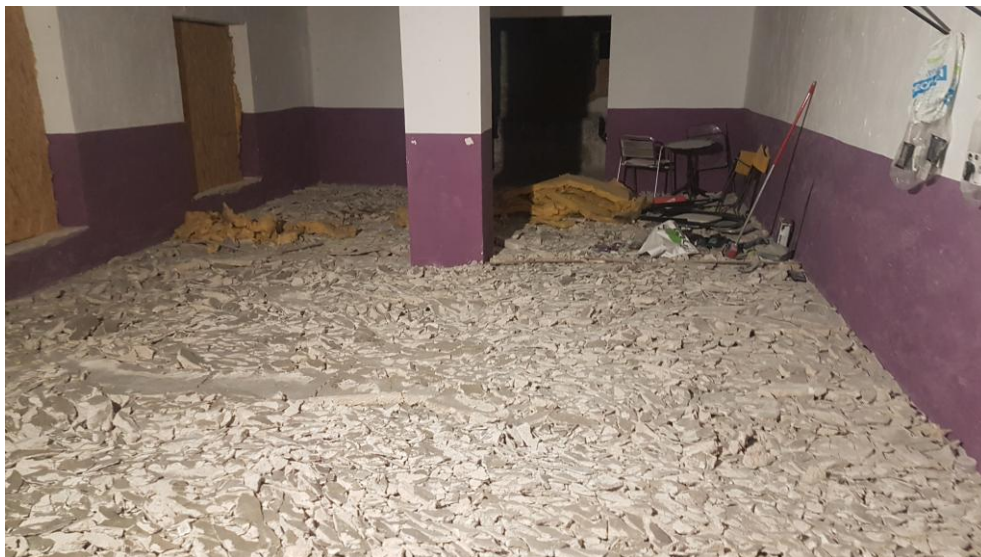
Planta baja (B13). Levante de capa de compresión
