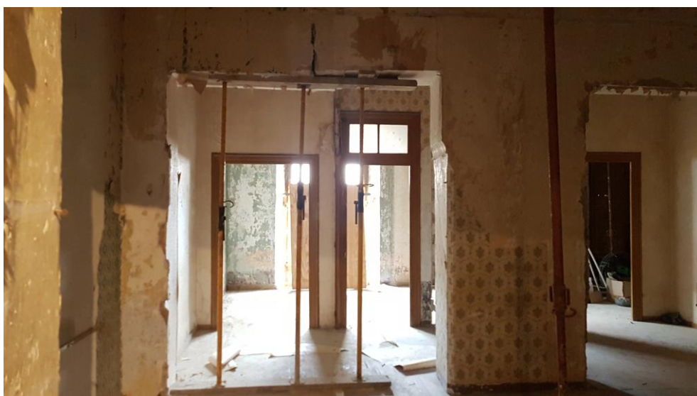
Entreplanta (E02b). Apoyo y acuña del dintel de un hueco de paso.
