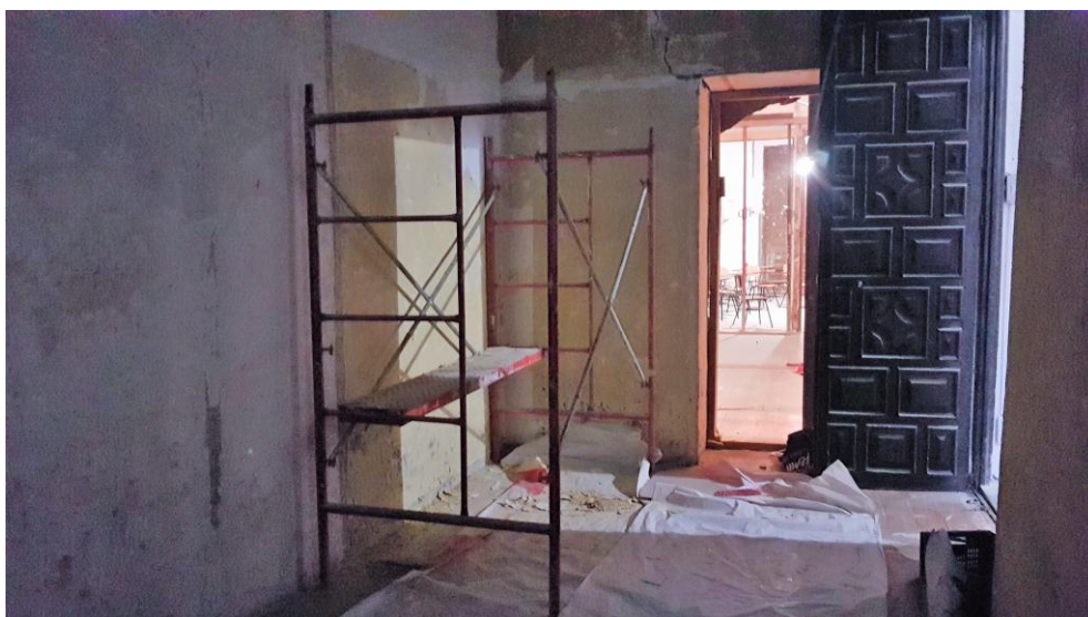
Planta primera (111a). Rascado y enlucido de paredes
