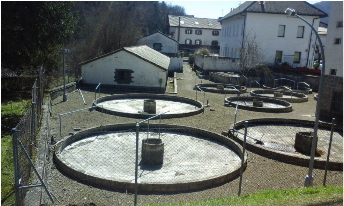
Imagen de las dos estructuras existentes, donde se realizará el “Deposito pulmón 1” y se dejará preparado para futura realización “Depósito pulmón 2”
