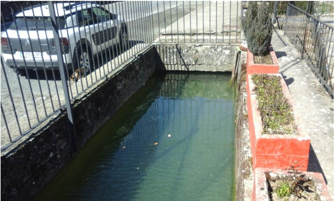
Aspecto actual zona donde realizar la toma de agua
