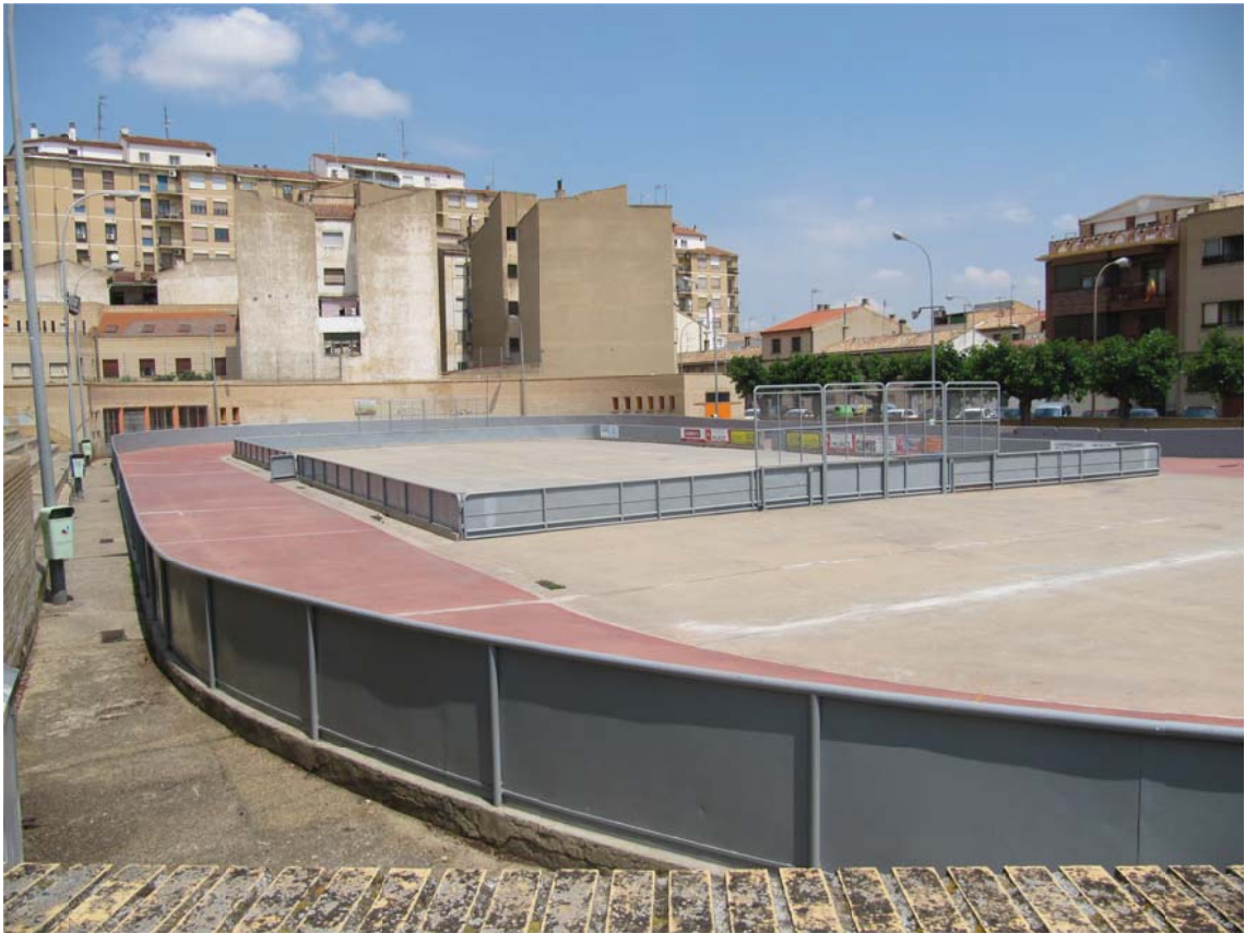
Vista general desde calle Ribaforada
