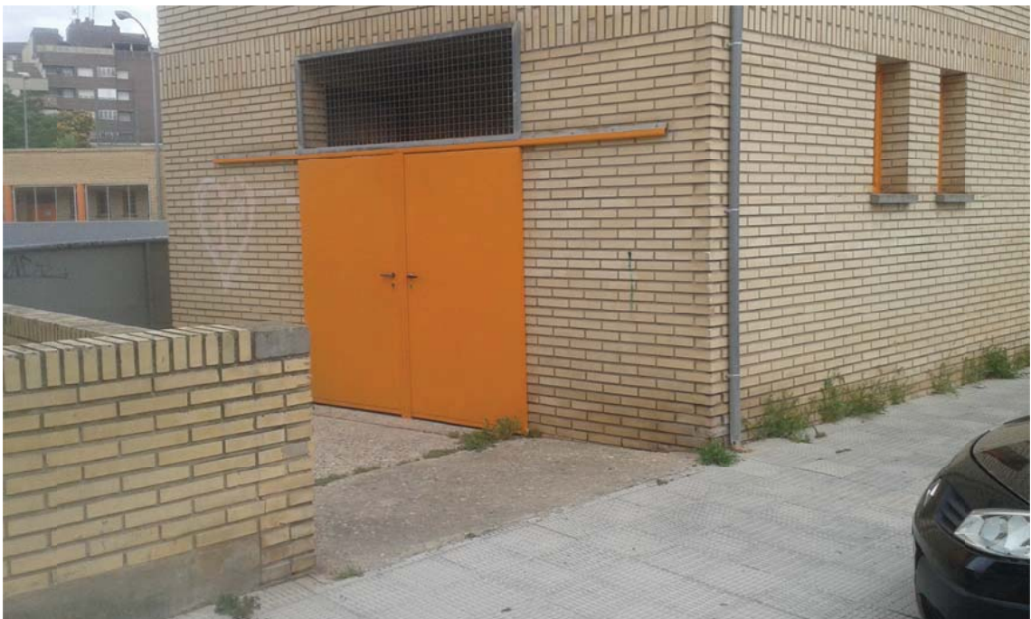
Vista zona futuros baños públicos y localización de la nueva puerta corredera motorizada y automatizada
