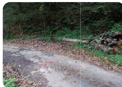
Foto 18 Vista pocillo ODT curva Pk1+110
