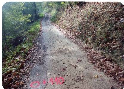
Foto 4. Pk0+110. Reposición margen MI
