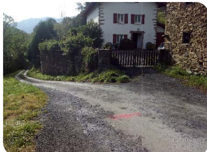
Foto 7. Pk0+865 (retroceso) Casa Spilenea
