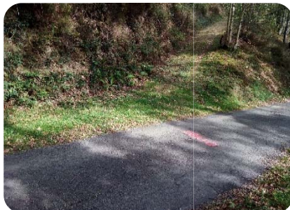
Foto 8. Pk0+380 sobreancho para cruce veh.
