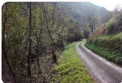
Foto 2. Pk0+100 (retroceso) Tramo 13%
