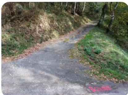
Foto 2.1. Pk2+000 inicio a Eunatenea.
