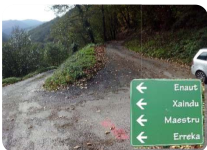
Foto 1. Pk0+000 Inicio tronco común
