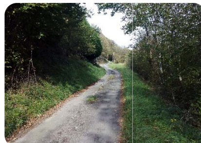
Foto 12 Pk0+800 (avance) vista casa Spilenea
