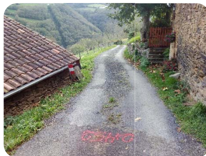
F30 Pk1+430 paso entre fachadas Edarreta
