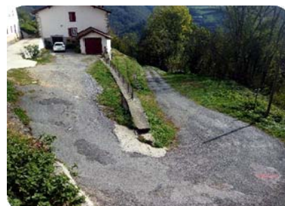
Foto 1.2. Acceso final Xainduenea Pk1+440
