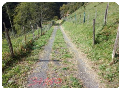
Foto 3.6. Pk3+160 Herbáceas y gravilla rodadura en bandas rodadura
