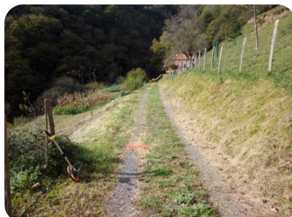
Foto 3.7. Pk3+220. Final del tramo de camino vallado desde el portillo del Pk3+070.
