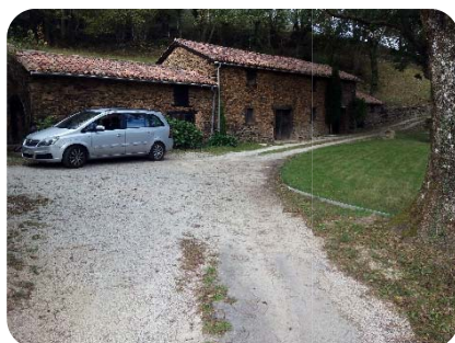
Foto 22. Pk1+225 Entrada paso casa Ttalo
