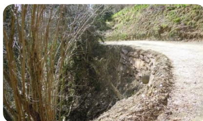
Foto 13. ODT Pk0+580 en momento ejecución
