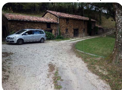
Foto 10. Pk1+225 Entrada paso casa Ttalo
