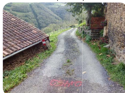
Foto 12. Pk1+430 paso entre fachadas Edarreta
