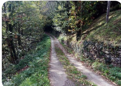
Foto 20. Pk1+200 (retroceso) subida a Ttalo
