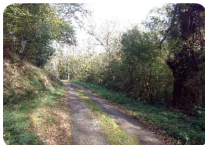
Foto 16. Pk1+050 sobreancho MI junto árbol
