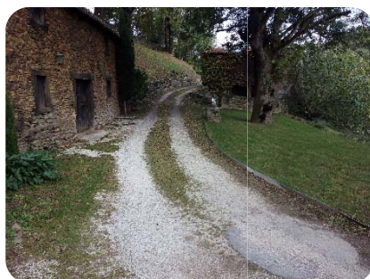
Foto 23. Pk1+250 Salida paso casa Ttalo
