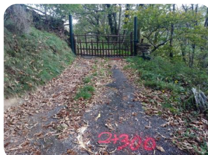
Foto 2.9. Pk2+300 Portillo final rodadura.
