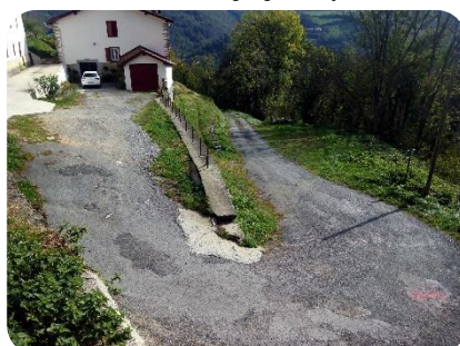
Foto 1.8. Pk1+440 “Y” ramal 30m
