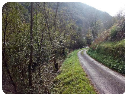
Foto 2. Pk0+100 (retroceso) Tramo 13%
