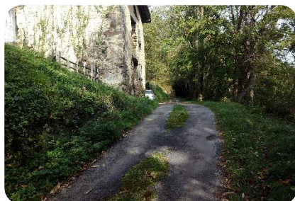
Foto 10. Pk1+500 Casa Maixterrenea Zaharra
