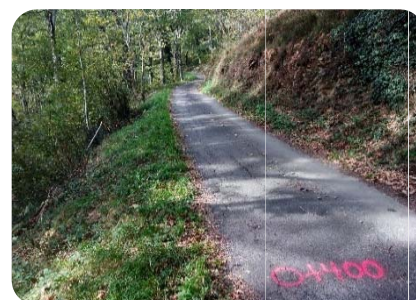
Foto 3. Pk0+400 Zona central tronco común
