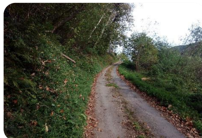
Foto 3. Pk0+200 (avance) tramo 13%
