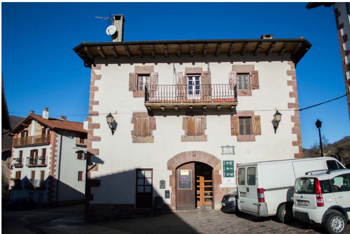
FACHADA PRINCIPAL EDIFICIO (ALZADO SURESTE)
