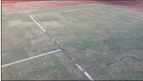
Estado pistas tenis actuales
