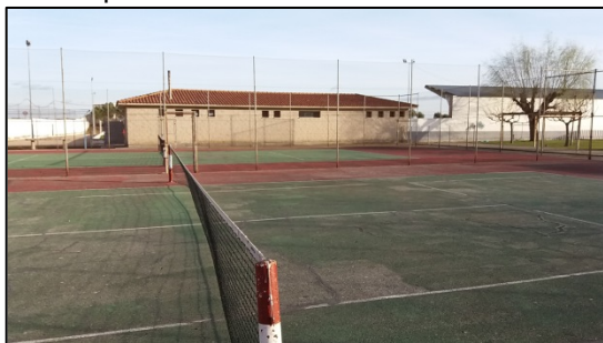
Vista general pistas de tenis
