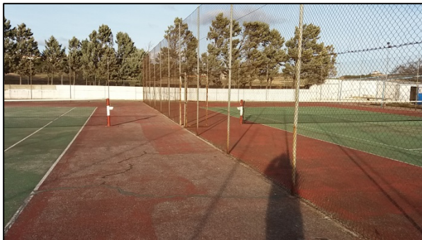
Estado pistas tenis 2
