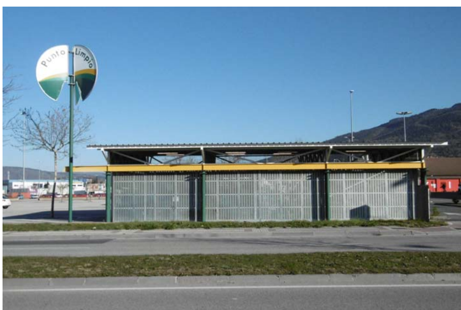
"Punto Limpio" MCP en el Aparcamiento del Hiper Eroski. Pamplona.
