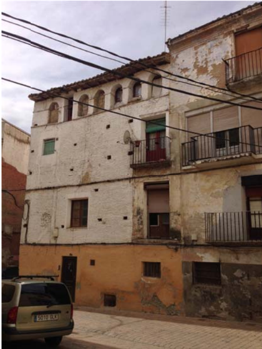
Vista desde calle Segundo Bajadero
