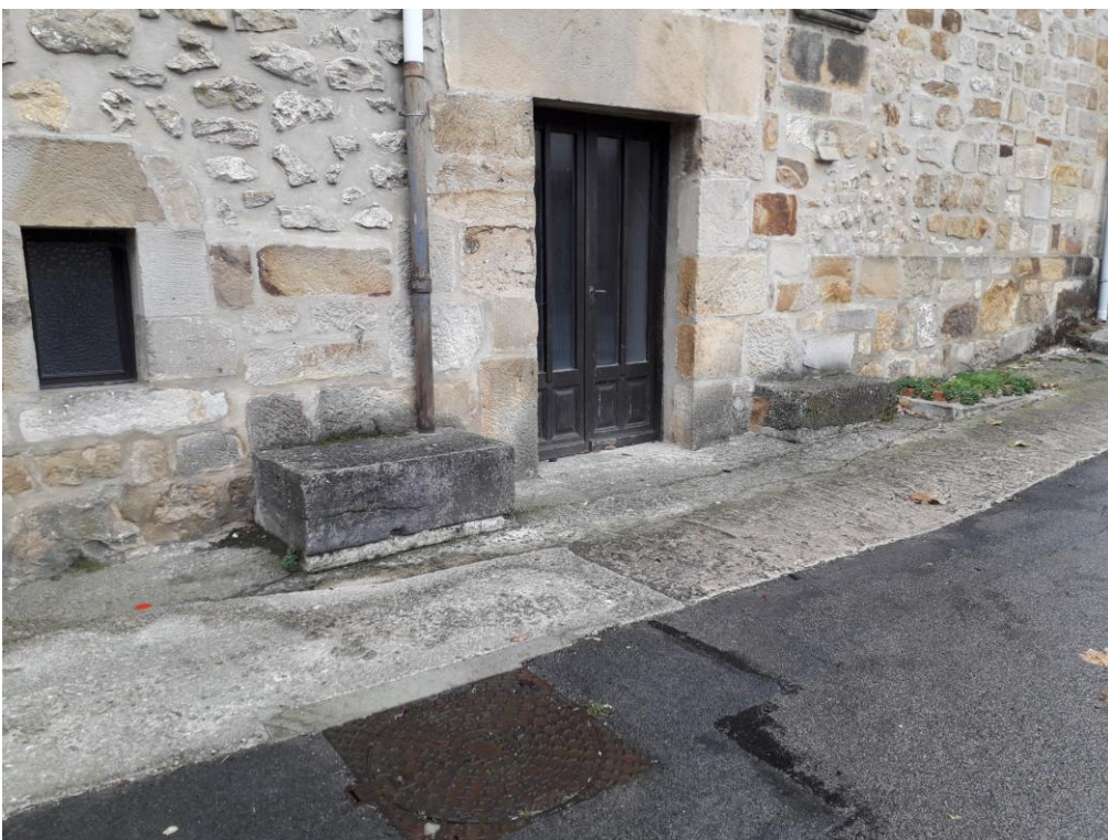
ACERA TRAMO 1 (M. DCHA.) CON ELEMENTOS (BANCO) A ELIMINAR
