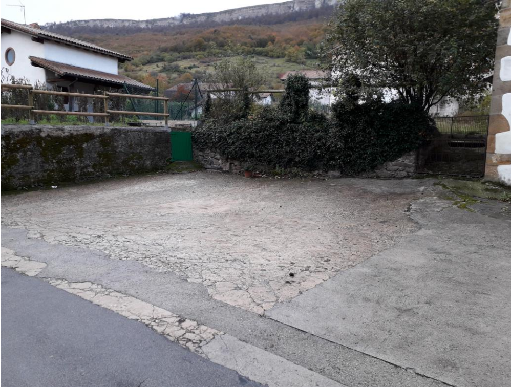
PLAZA 2ª MARGEN DERECHA: ZONA EN LA QUE ES NECESARIO REGULAR LOS APARCAMIENTOS Y LOS DISTINTOS ACCESOS
