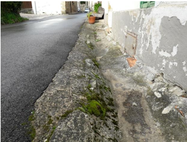
UMBRAL BAJO LA RASANTE DE LA CALLE (PORTAL Nº 7) QUE SE RESOLVERÁ CON LA COLOCACIÓN DE UNA REJILLA FRENTE A LA PUERTA DE ACCESO
