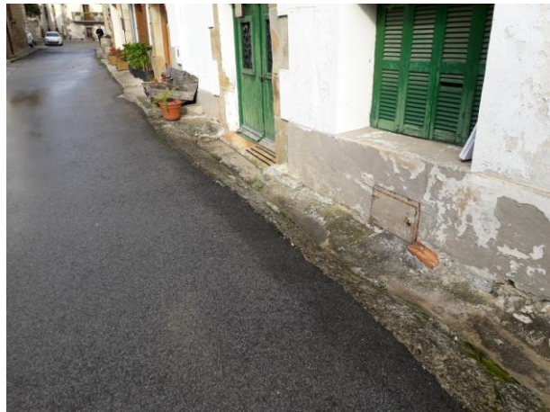
UMBRAL BAJO LA RASANTE DE LA CALLE (PORTAL Nº 7) QUE SE RESOLVERÁ CON LA COLOCACIÓN DE UNA REJILLA FRENTE A LA PUERTA DE ACCESO
