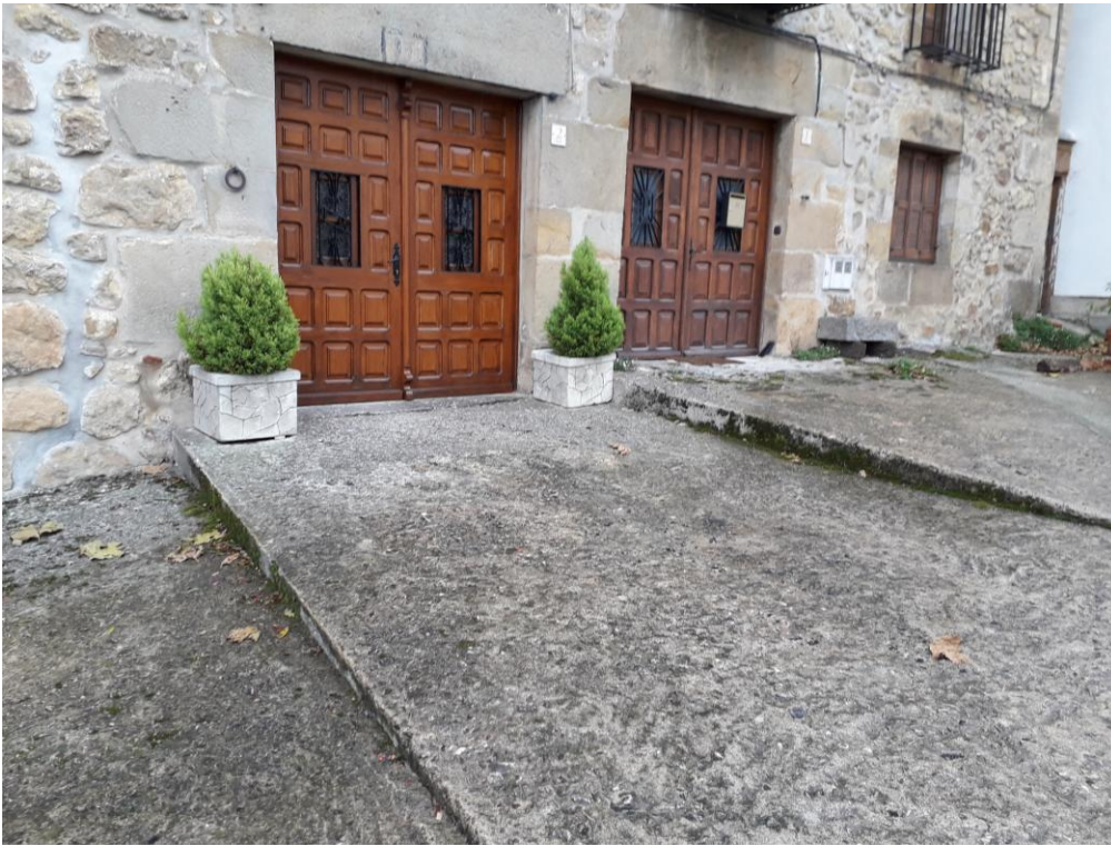
PELDAÑEADO EXISTENTE EL 1ª PLAZA M. DCHA. QUE PUEDEN RESOLVERSE CON RAMPAS
