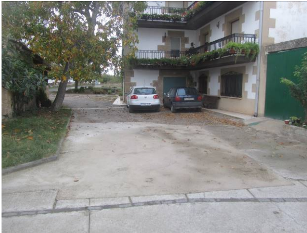
Foto nº 9: Calle Barrio el Monte
