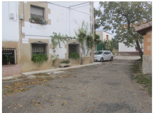
Foto nº 1: Calle Barrio el Monte 2
