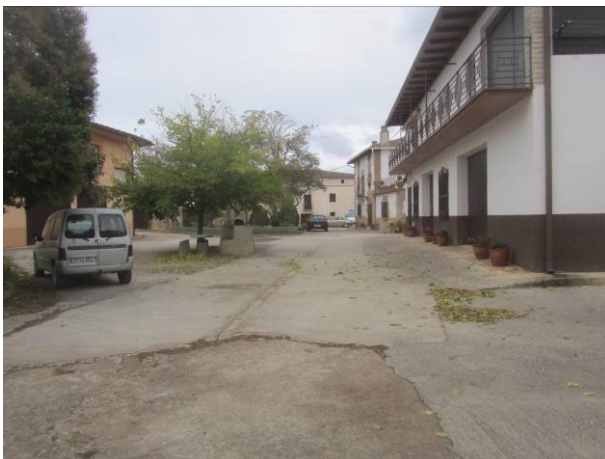
Foto nº 5: Calle Barrio el Río
