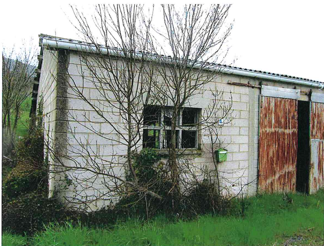
ESTABLO-APRISCO EN LA CALLE CARROBIDE Nº 4 DE ZULUETA VISTAS DE LA FACHADA NORTE Y DE LA PUERTA LATERAL
