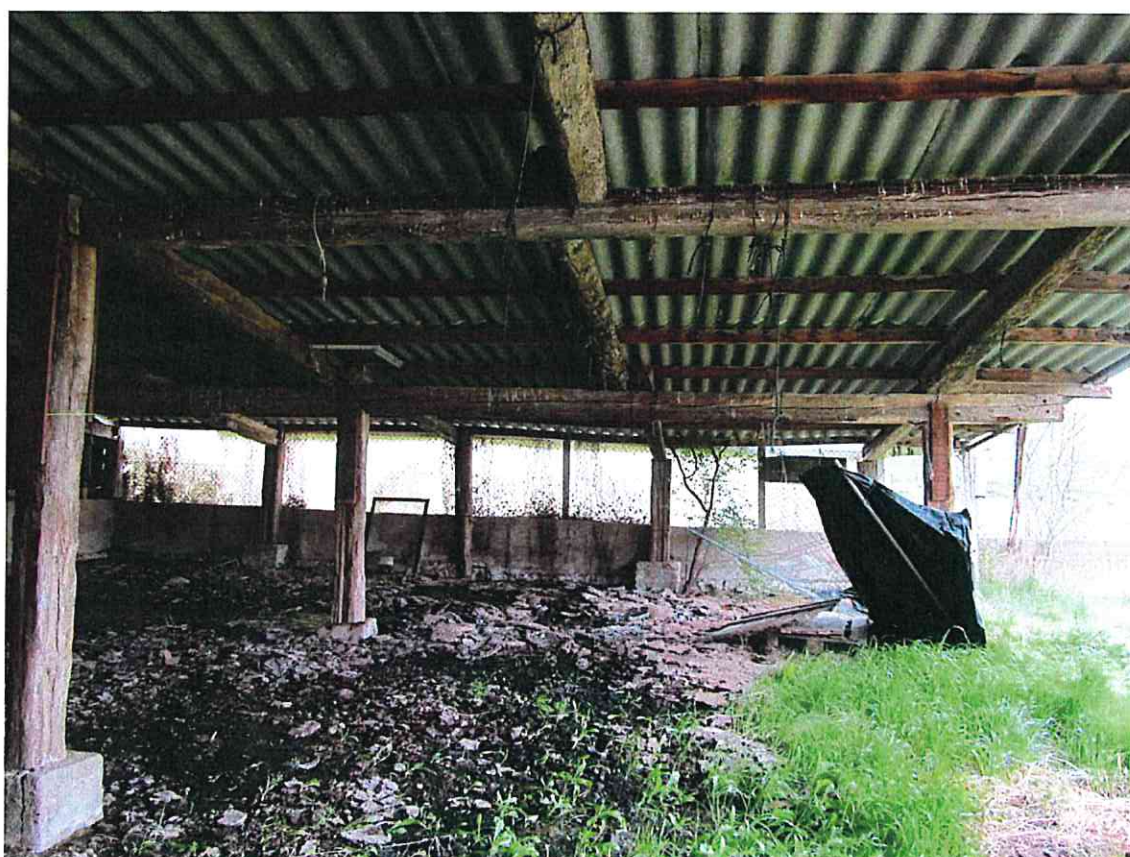
ESTABLO-APRISCO EN LA CALLE CARROBIDE Nº 4 DE ZULUETA VISTAS DE LA TEJAVANA QUE CUBRE PARTE DEL PATIO
