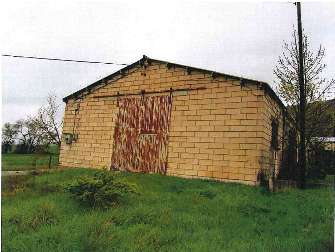
ESTABLO-APRISCO EN LA CALLE CARROBIDE Nº 4 DE ZULUETA VISTAS DEL ACCESO Y DE LA FACHADA SUR
