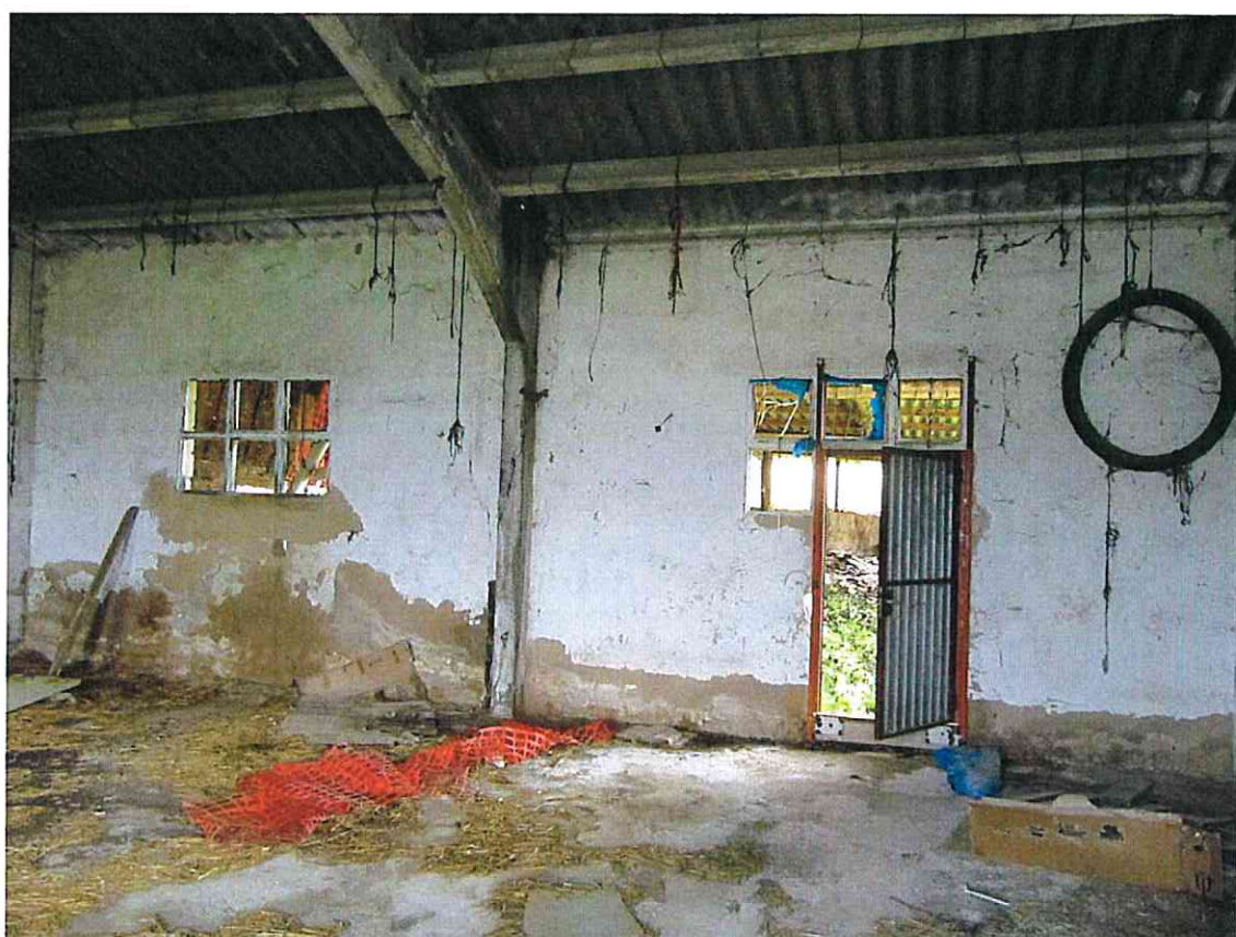
ESTABLO-APRISCO EN LA CALLE CARROBIDE Nº 4 DE ZULUETA VISTAS DE LA ZONA SEPARADA DE ALMACÉN DE LA NAVE
