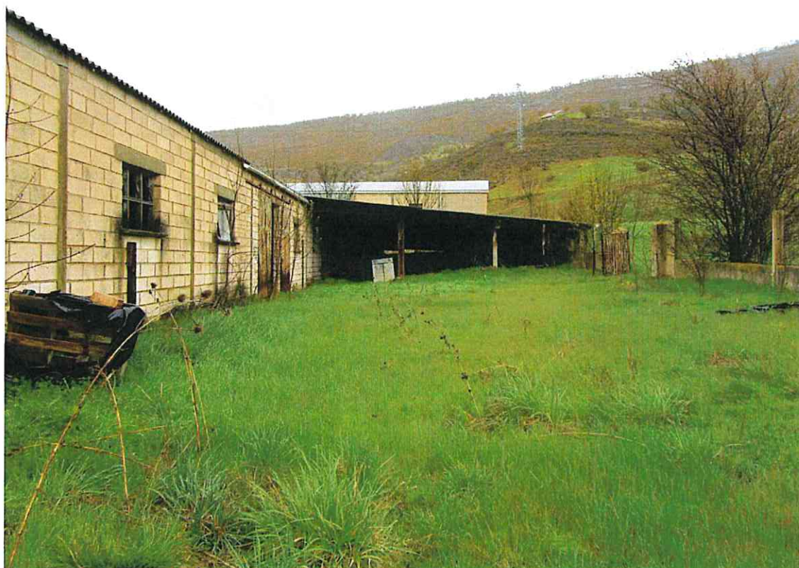
ESTABLO-APRISCO EN LA CALLE CARROBIDE Nº 4 DE ZULUETA VISTAS DEL PATIO CON LA TEJAVANA AL FONDO
