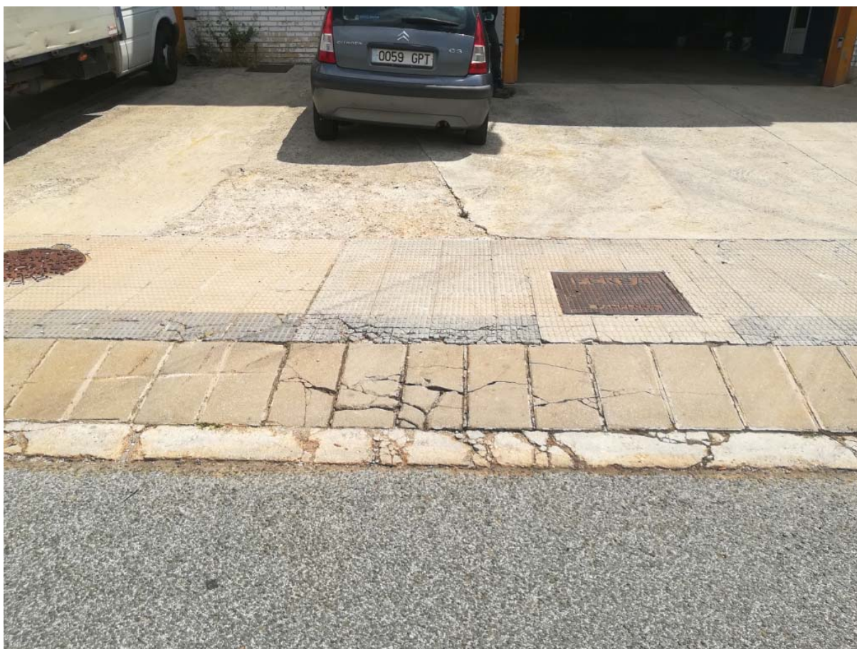
07 Reposición de baldosa acera (6,40 m 2 ), rebaje de losas de hormigón y rigola (6,00 m)
