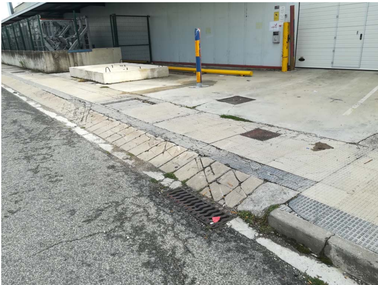
16 Reposición acera (solera + pavimento baldosas), rebaje de hormigón y rigola (8,40 m)
