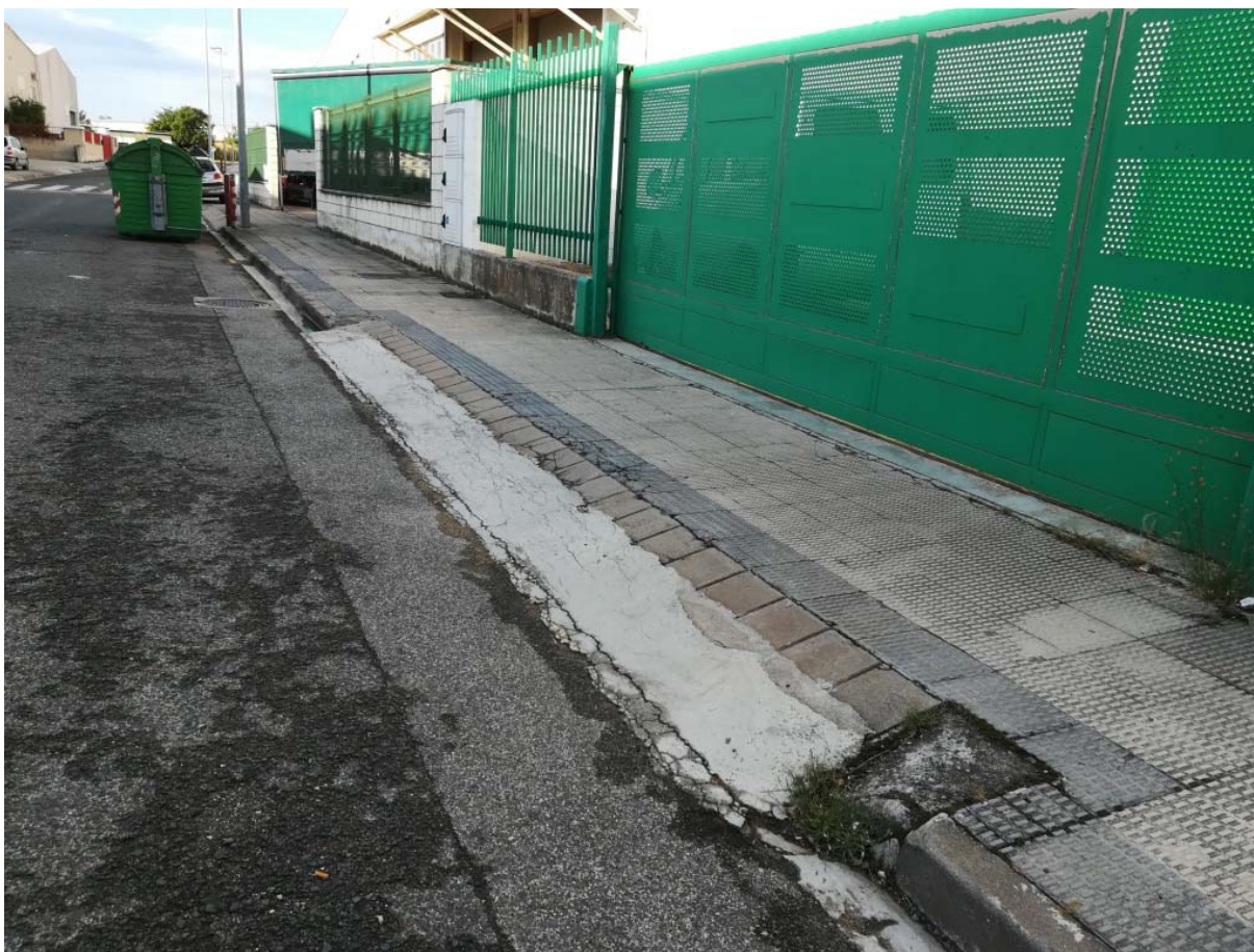
21 Reposición pavimento baldosa (4,80 m 2 ) y rebaje de hormigón y rigola (8,00 ml)
