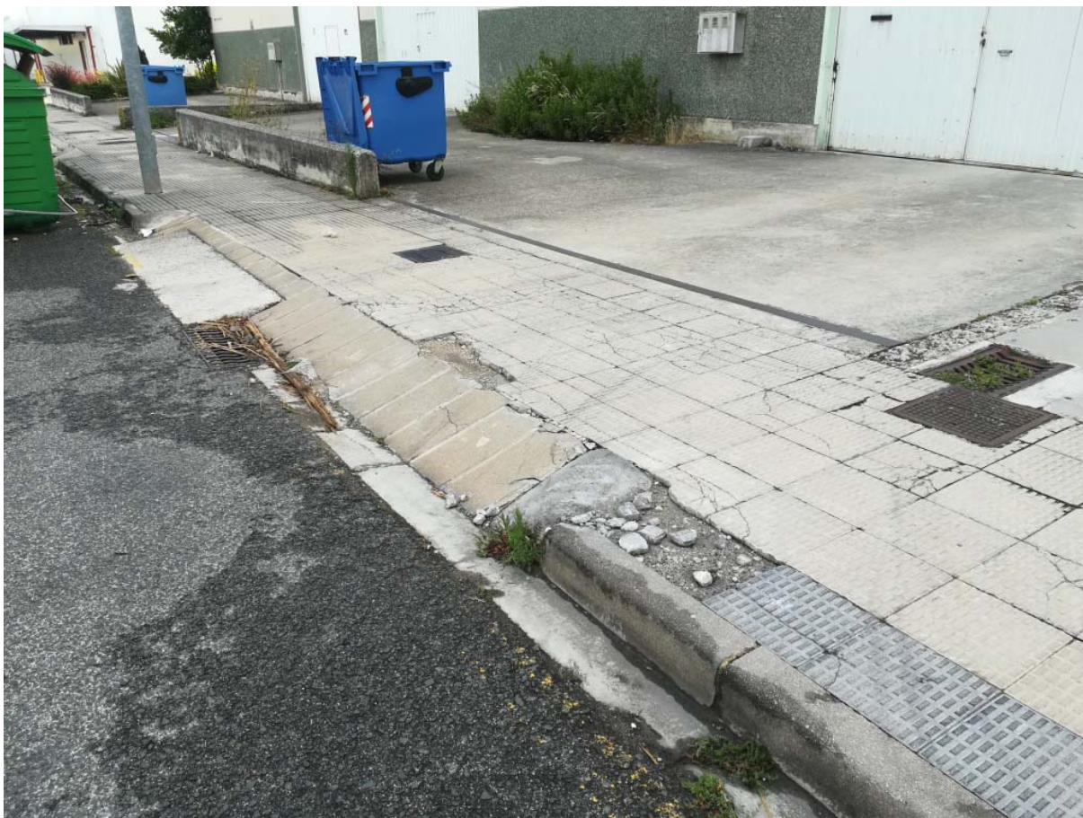
18 Reposición pavimento baldosa (12,60 m 2 ), rebaje de hormigón y rigola (13,80 ml)
