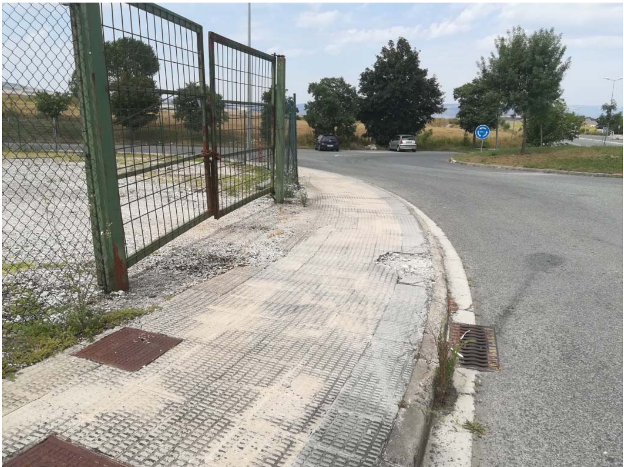
05 Reposición de baldosa en acera (12,75 m 2 ), rebaje de hormigón y rigola (8,50 m)
