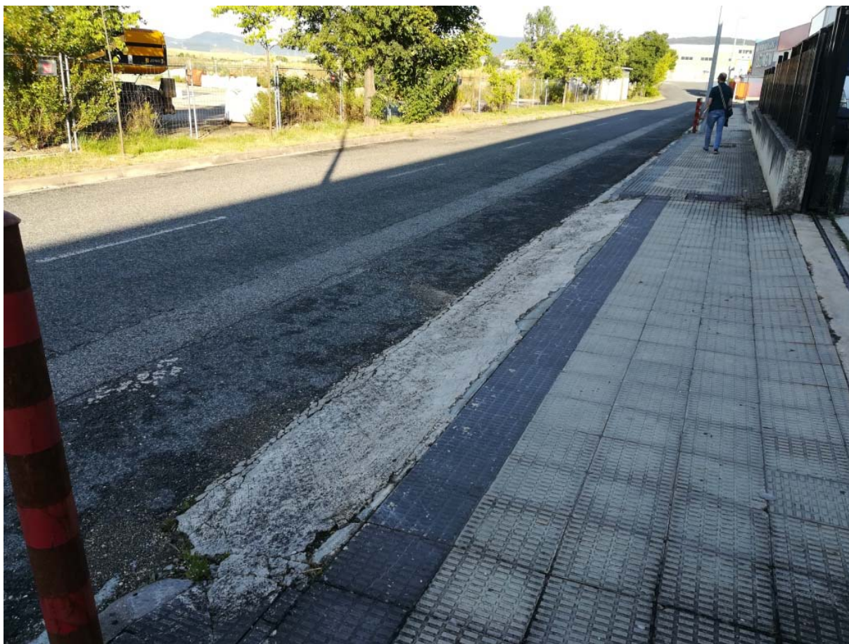
27 Reposición rebaje hormigón, rigola y 1ª fila baldosa (8,50 ml)
