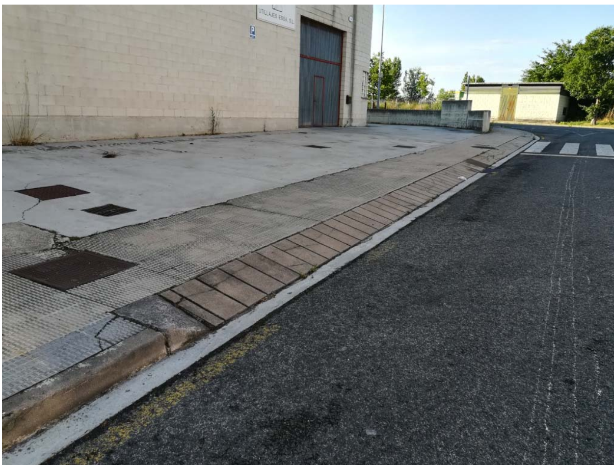
28 Reposición pavimento baldosa (4,0 m 2 ) y rebaje losas de hormigón (5,0 m)
