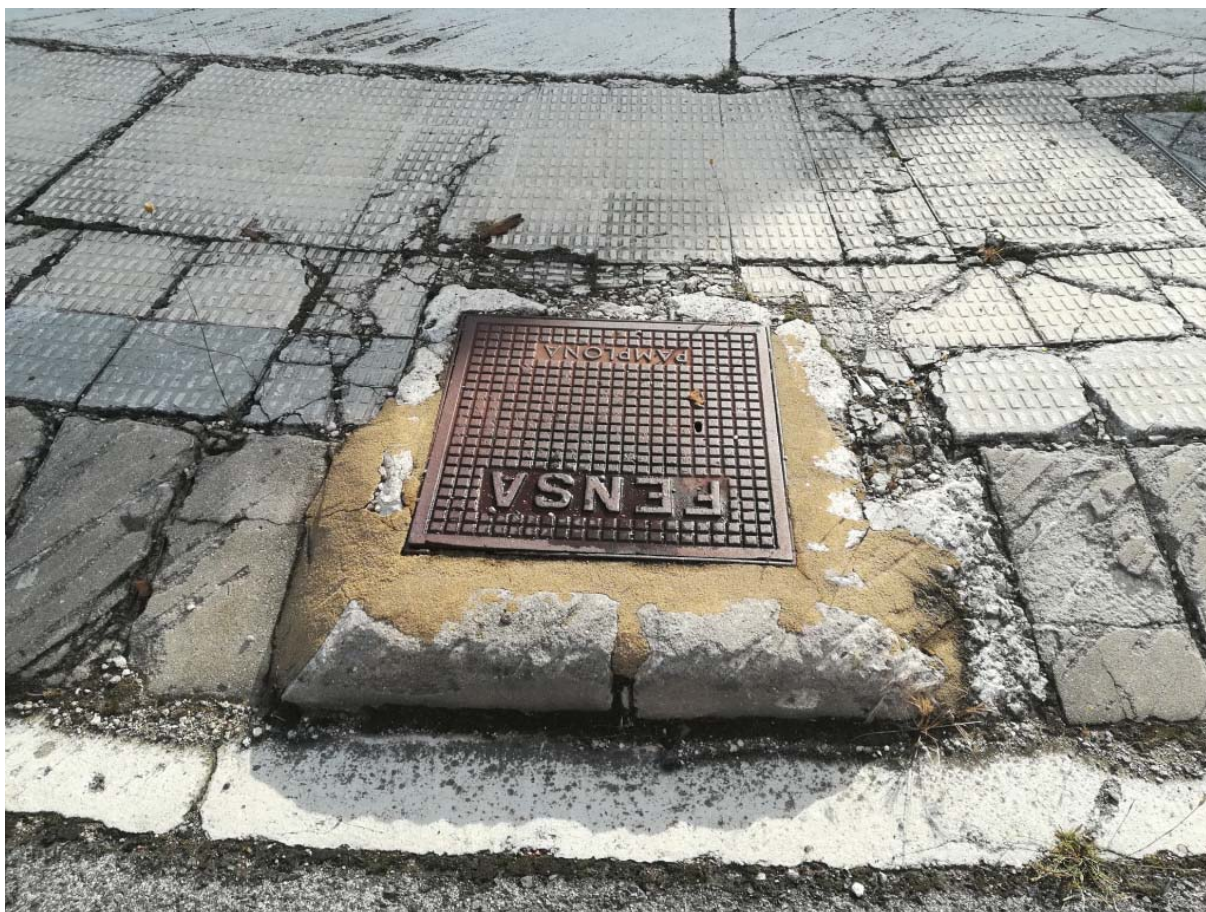
17 Reposición pavimento baldosa (6,0 m 2 ) y rebaje de losas de hormigón (1,0 m)
