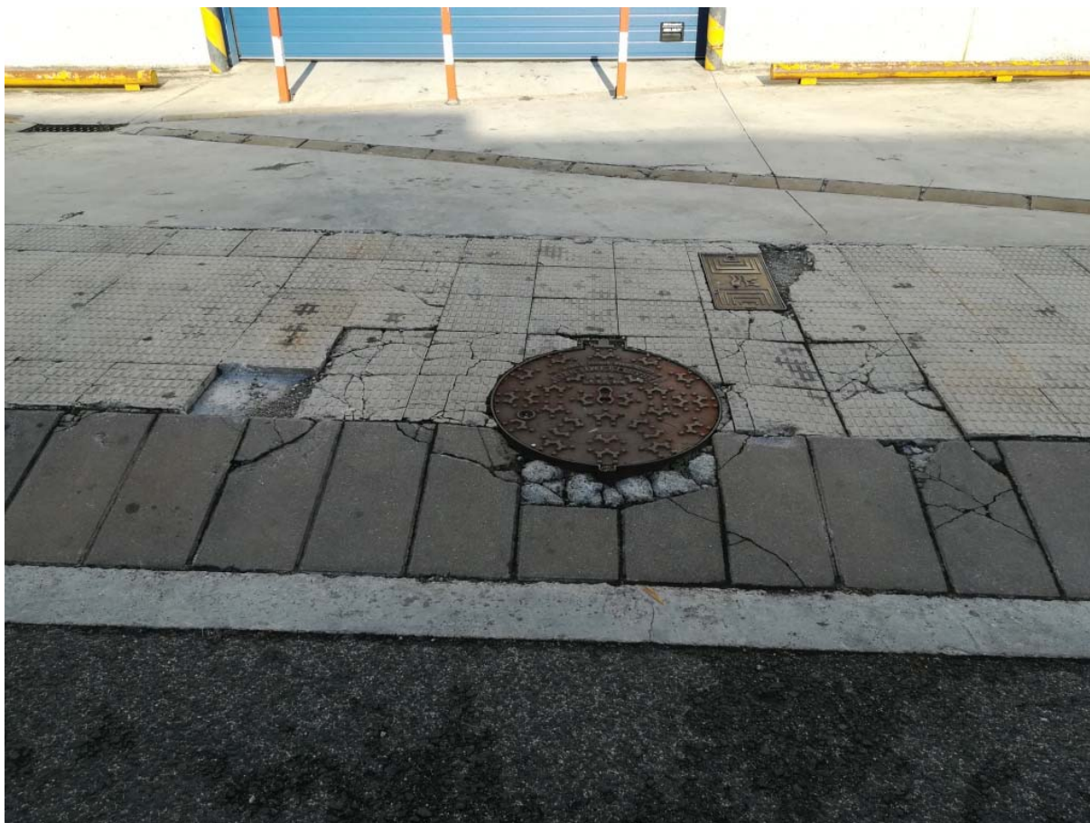
23 Reposición pavimento baldosa (6,00 m 2 )
