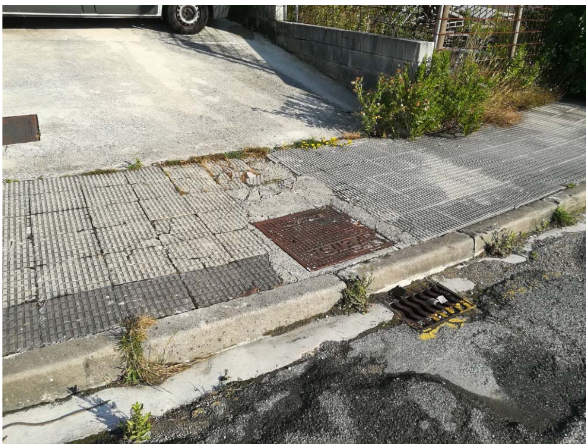
24 Reposición pavimento baldosa (3,50 m 2 )
