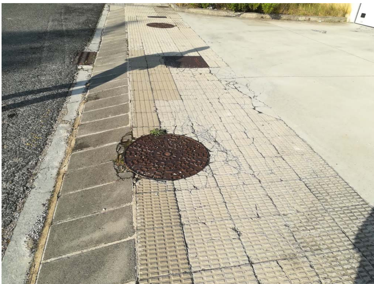
26 Reposición pavimento baldosa (6,75 m 2 )
