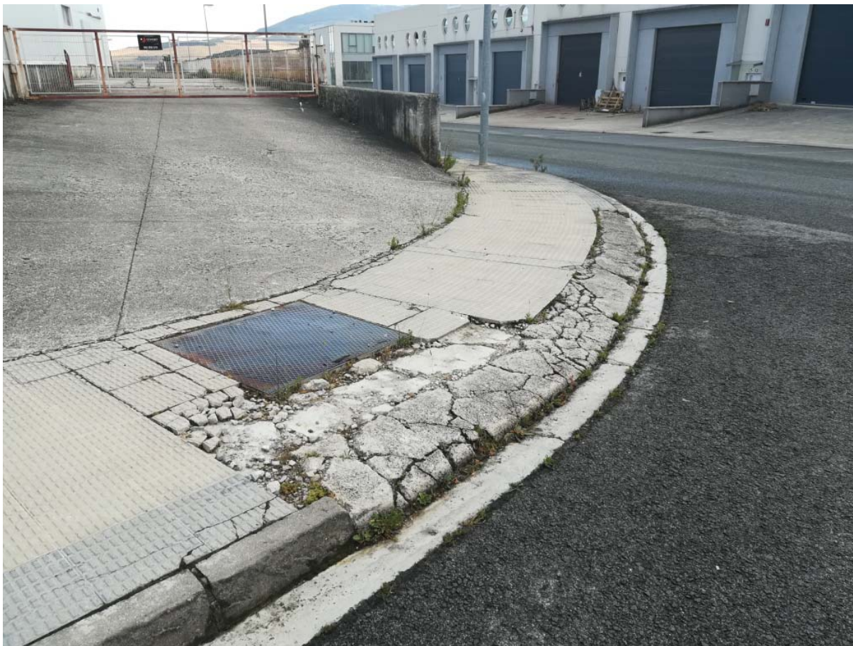
15 Reposición pavimento baldosa (11,70 m 2 ) y rebaje de hormigón y rigola (7,80 ml)
