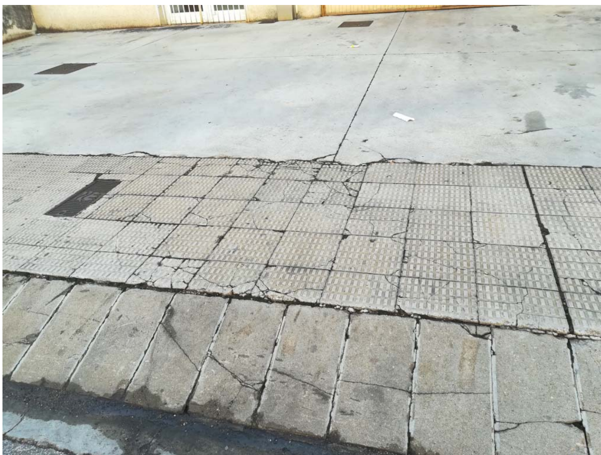
29 Reposición rebaje hormigón y rigola (11,50 ml) y pavimento baldosa (10,00 m²)
