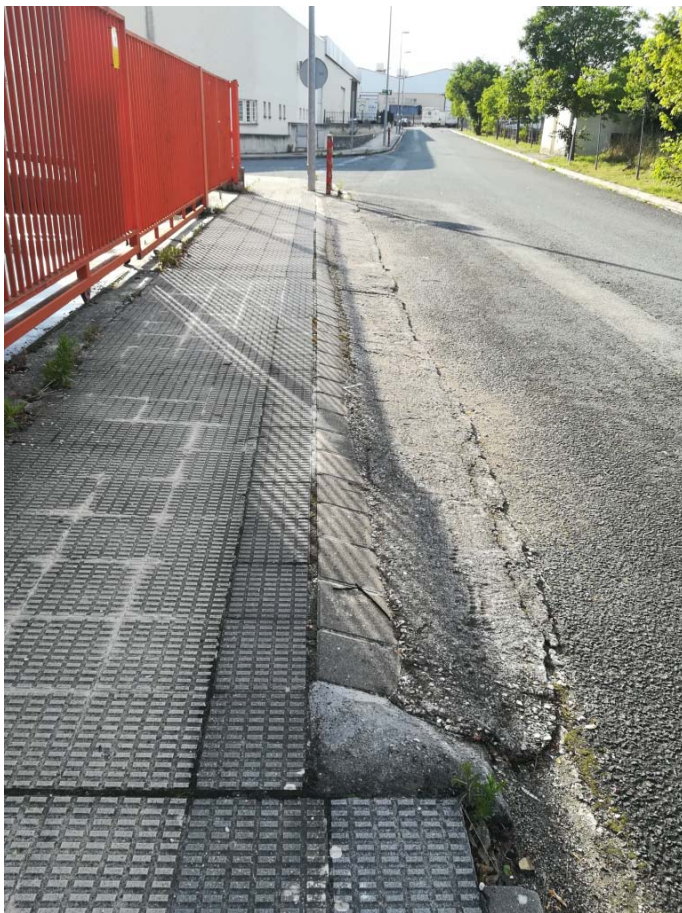
19 Reposición rebaje hormigón, rigola y 1ª fila baldosa (15,10 ml)
