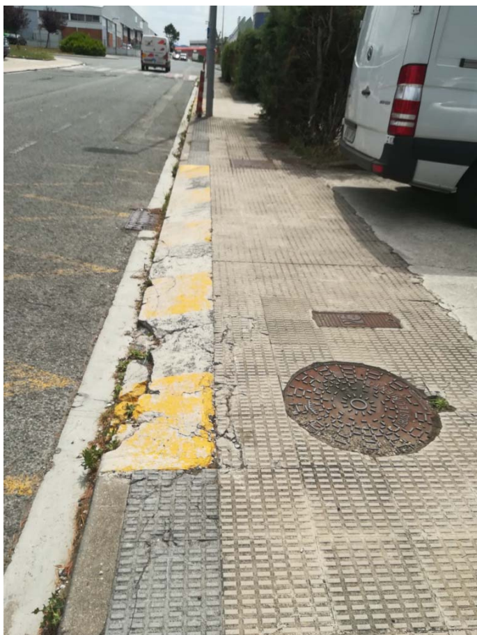
06 Reposición rebaje hormigón, rigola y 1ª fila baldosa (6 m)
