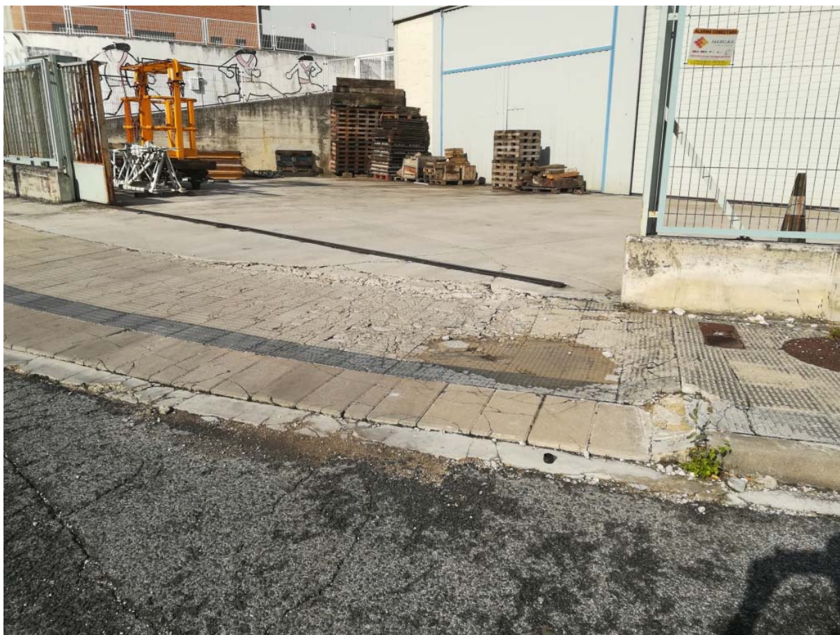
14 Reposición acera (solera + pavimento baldosas), rebaje de hormigón y rigola (11,5 ml)
