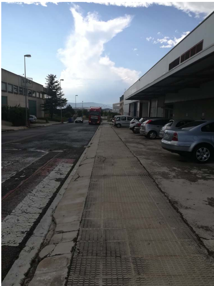
11 Reposición rebaje de losas de hormigón y rigola (37,6 m) y baldosas acera (32,4 m 2 )
