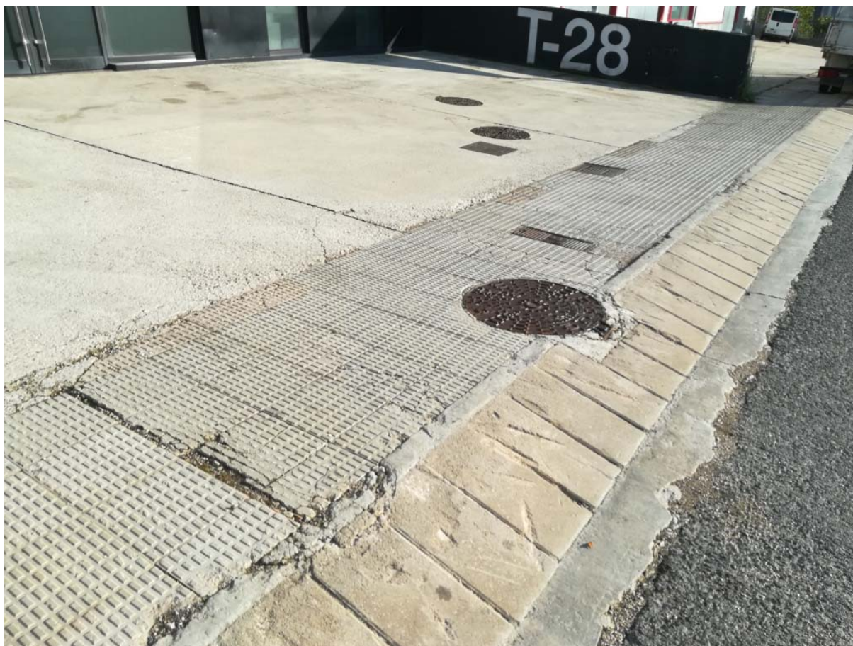
25 Reposición pavimento baldosa (6,75 m 2 )
