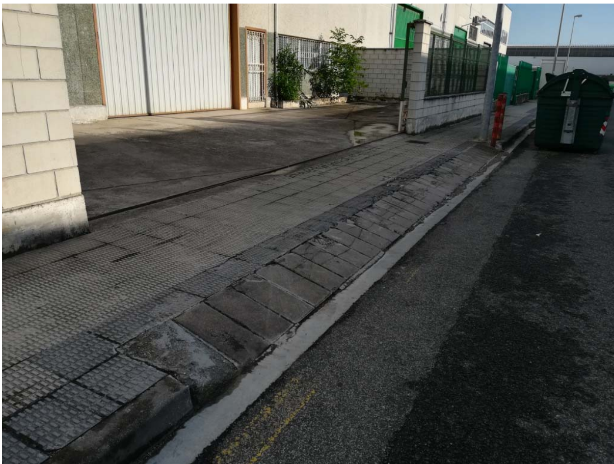
20 Reposición pavimento baldosa (15,00 m 2 ) y rebaje de hormigón y rigola (10,00 ml)
