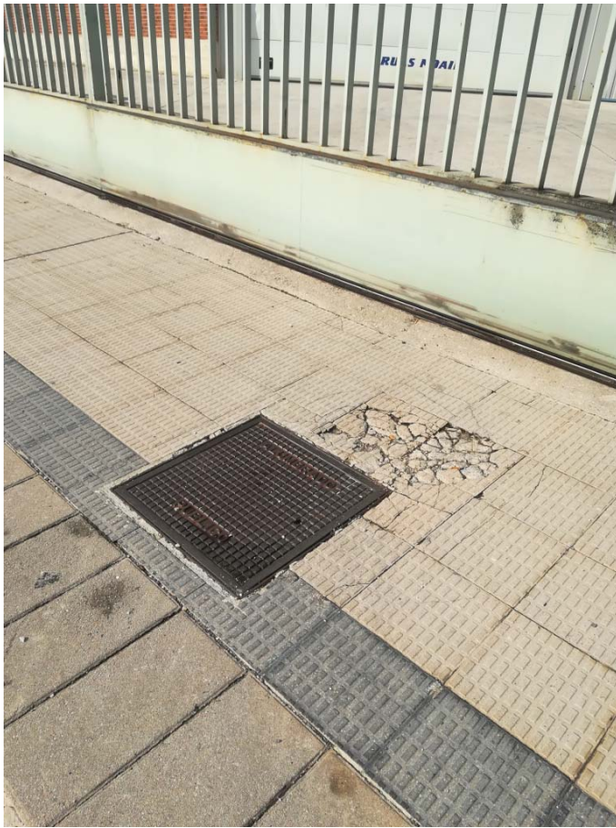
13 Reposición pavimento baldosa (1,80 m 2 ) y remates laterales de rebajes de hormigón (2)
