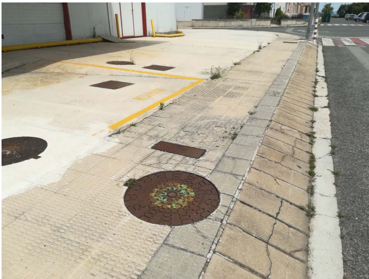
08 Reposición de baldosa de acera y rebaje de losas de hormigón (5 m)
