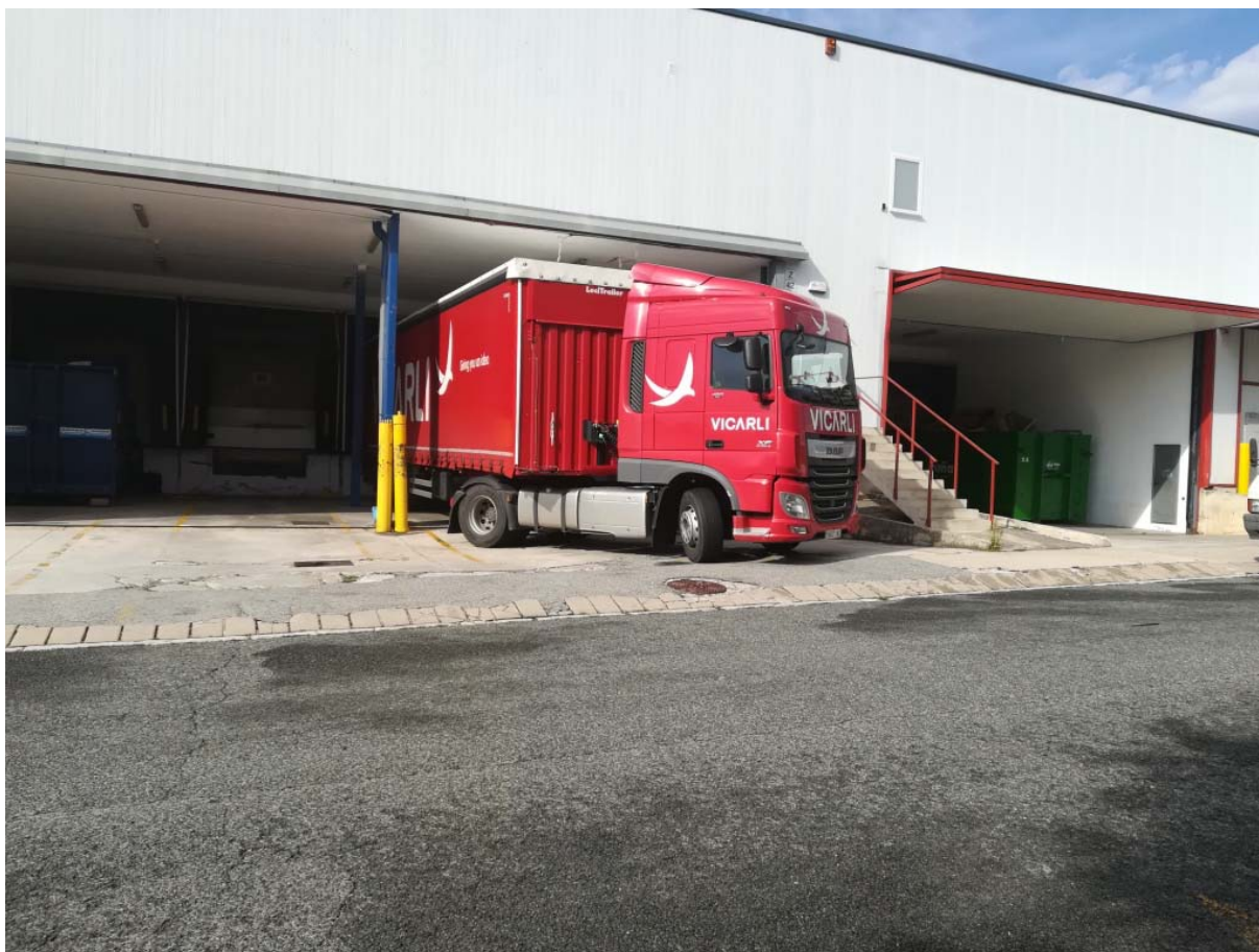
12 Sustitución de acera por hormigón i/ rigola (49,5 ml)
