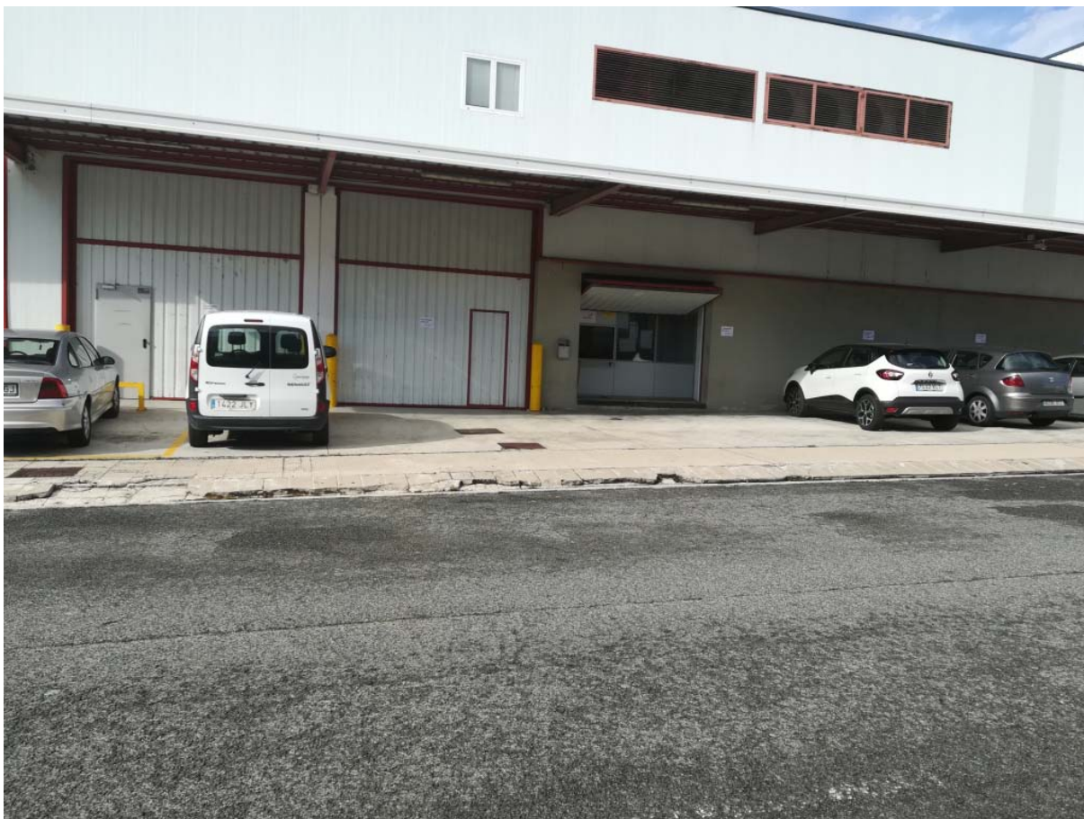
11 Reposición rebaje de losas de hormigón y rigola (37,6 m) y baldosas acera (32,4 m 2 )
