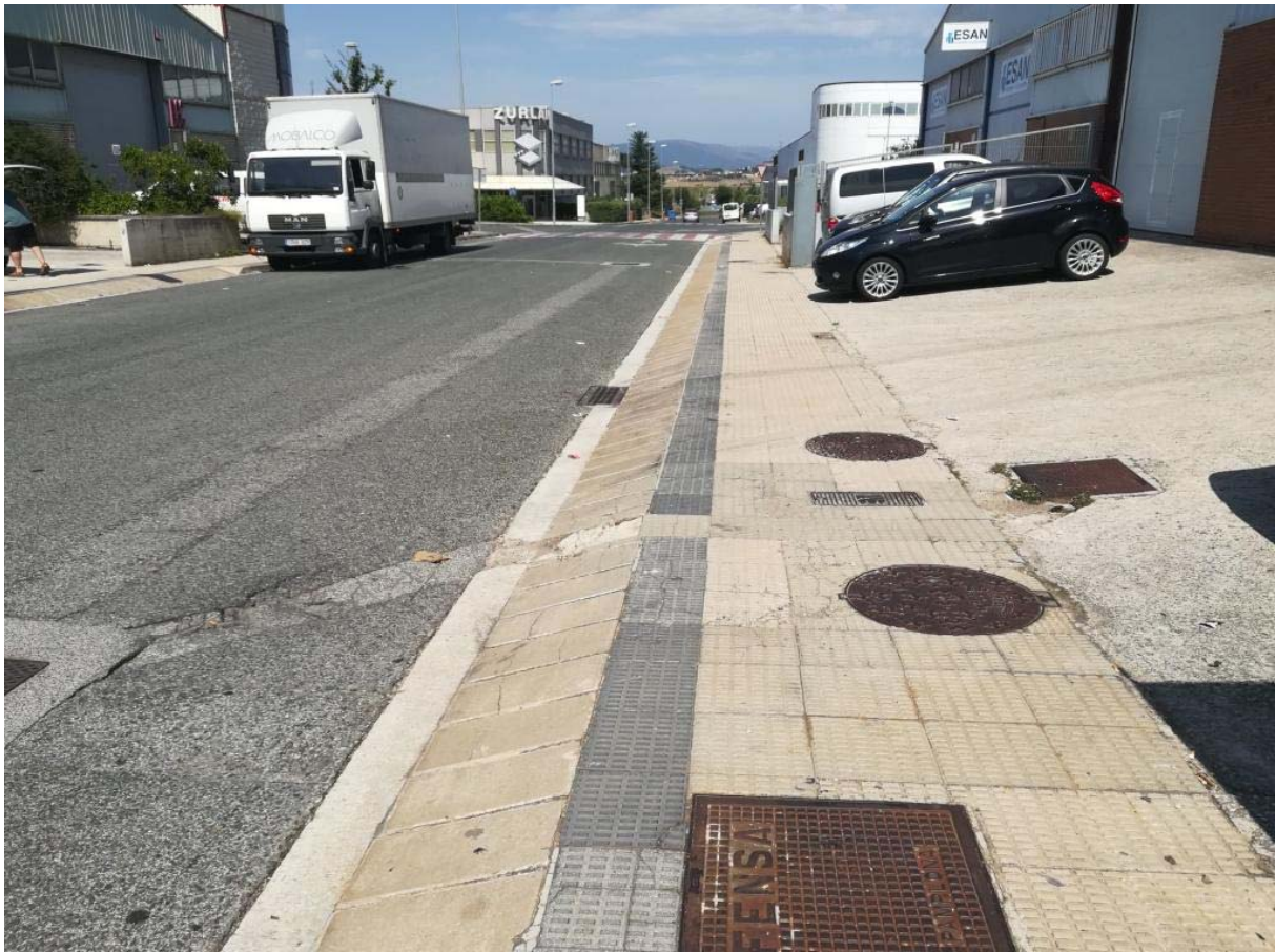
01 Reposición de baldosa en acera y rebaje de losas de hormigón (8m)
