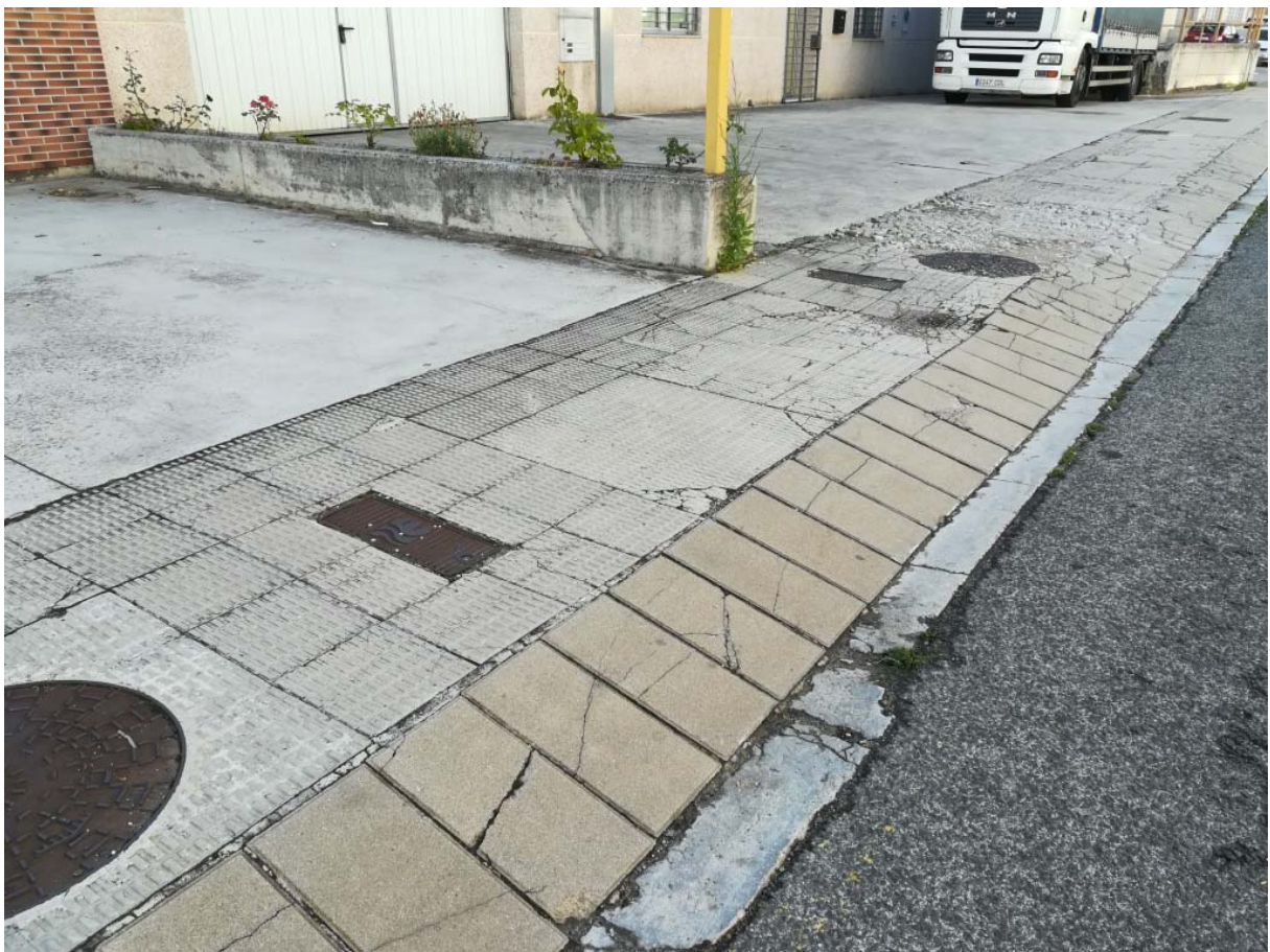
30 Reposición de acera (solera + pavimento baldosa) y rebaje de hormigón y rigola (16,60 m)
