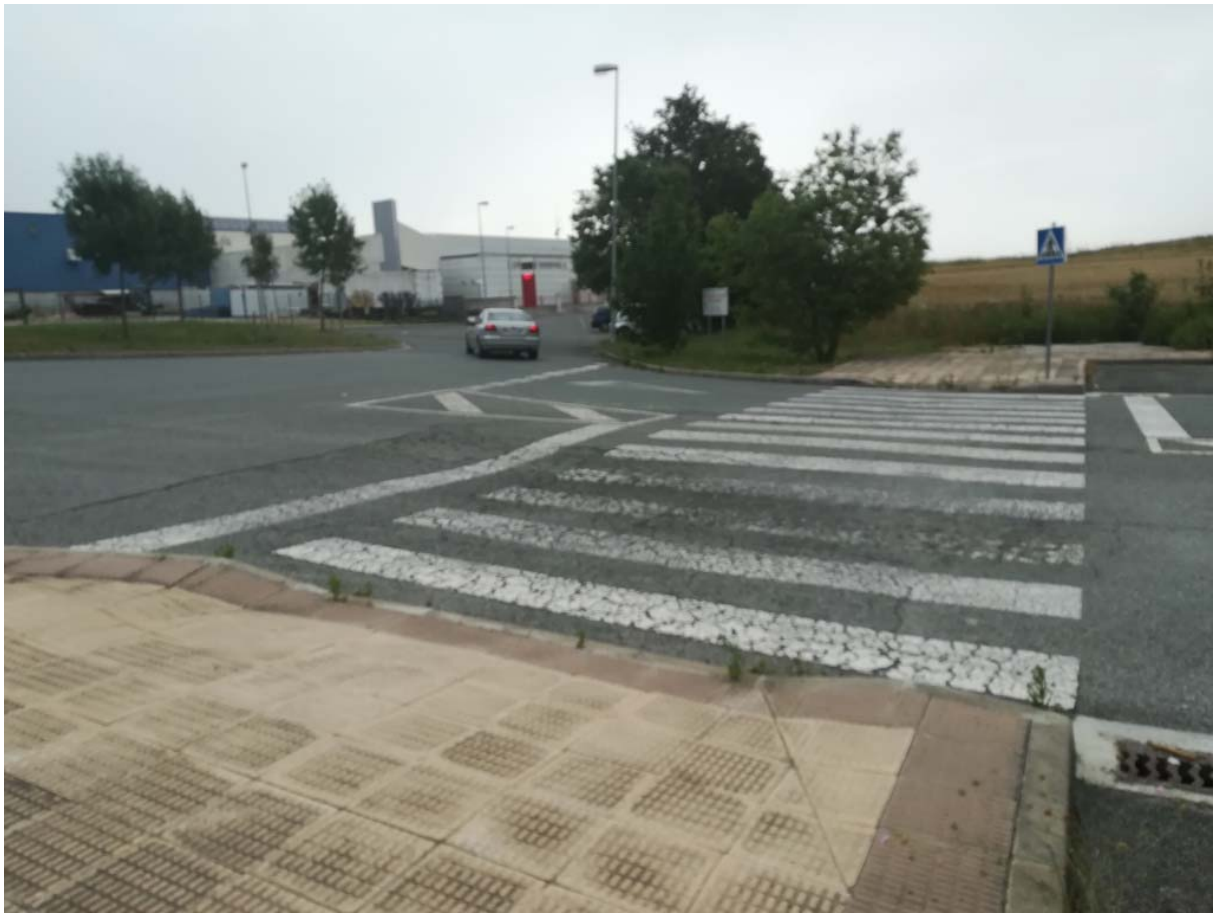
10 Arreglo de blandón: sub-base, base y pavimento (48 m 2 ) y pintura paso de peatones
