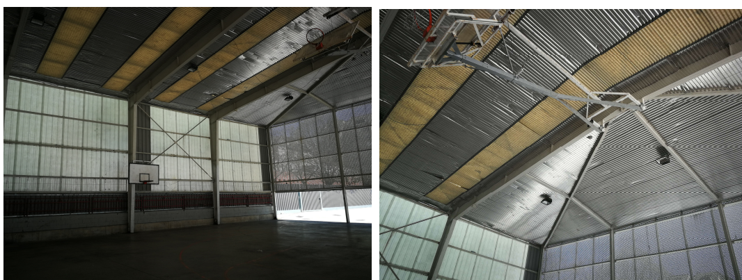
Efecto de la entrada de palomas: abombamiento chapa
