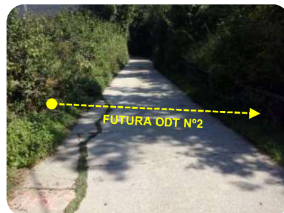
Foto 6. Pk0+040 actuación (avance)
