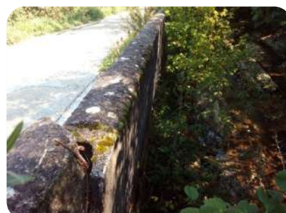
Foto 15. Pk0+030 Vista caída al Echarro.
