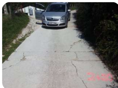
Foto 23. Pk2+020 acceso Kolantzuri (avance)
