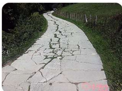
Foto 10. Pk0+090 camino Urepel (avance)
