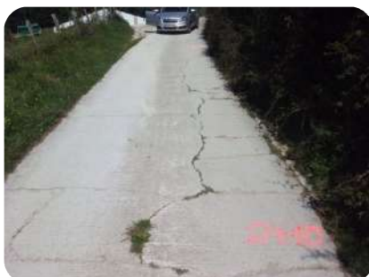
Foto 22. Pk2+010 camino Urepel (avance)
