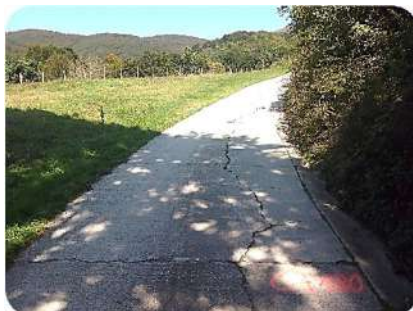
Fot 19. Pk0+180 Inicio tramo a sano (avance)
