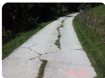
Foto 12. Pk0+110 camino Urepel (avance)
