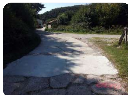
Foto 9. Pk0+030 actuación (retroceso)
