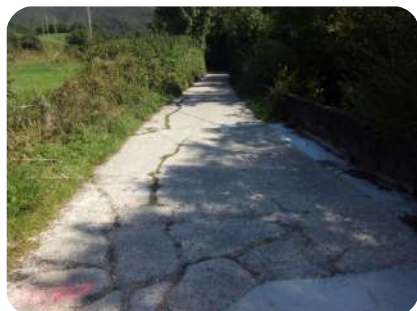
Foto 4. Pk0+030 actuación (avance)
