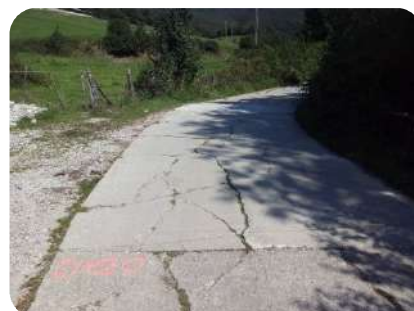
Foto 3. Pk0+020 actuación (avance)
