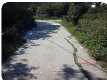
Foto 8. Pk0+040 actuación (retroceso)
