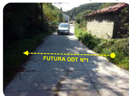
Foto 12. Pk0+010 actuación (retroceso.)
