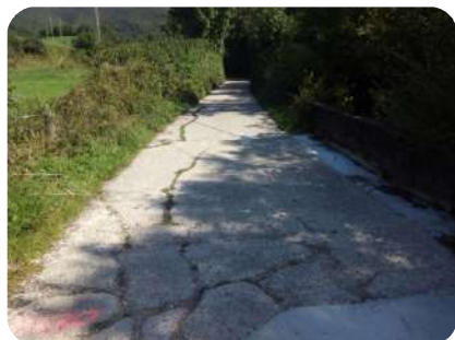
Foto 4. Pk0+030 actuación (avance)
