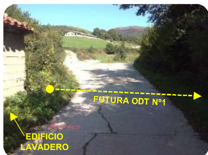
Foto 1. Pk0+000 Inicio actuación (avance)
