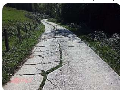
Foto 15. Pk0+150 previo ODT (retroceso)
