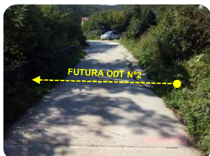
Foto 7. Pk0+048 Final actuación (retroceso)
