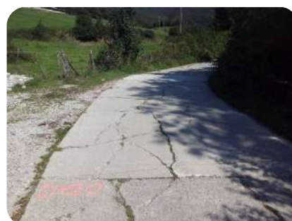
Foto 3. Pk0+020 actuación (avance)
