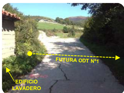
Foto 1. Pk0+000 Inicio actuación (avance)
