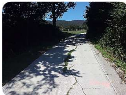
Foto 18. Pk0+160 camino Urepel (avance)
