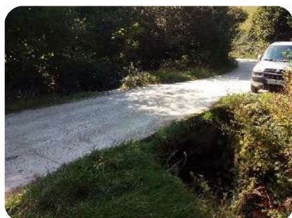
Foto 1. Pontón sobre regata Echarro
