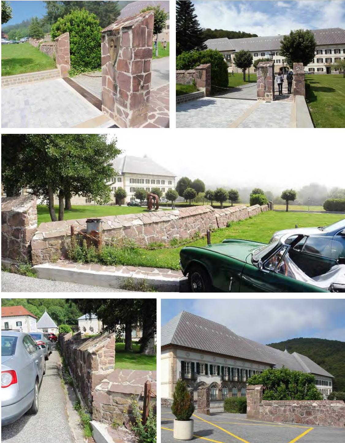
Vistas de la cara exterior del muro
