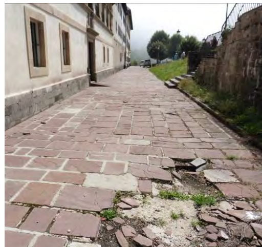
Estado en el que se encuentra la losa de la zona pavimentada frente a la Casa Prioral
