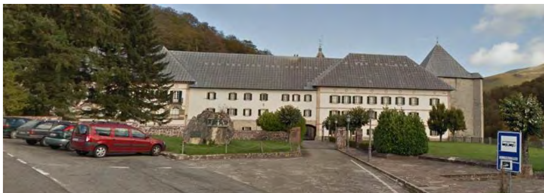
Imagen de Google Street View del año 2013, anterior a la ejecución en 2016-2017 del proyecto de "Rehabilitación del entorno de las capillas de Santiago y del Espíritu Santo"
