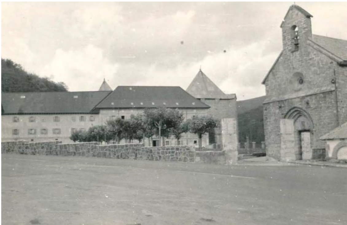
Fotografías en las que se ve el muro ejecutado a mediados de la década de los 50 y la carretera asfaltada. Archivo de la Real Colegiata de Roncesvalles
