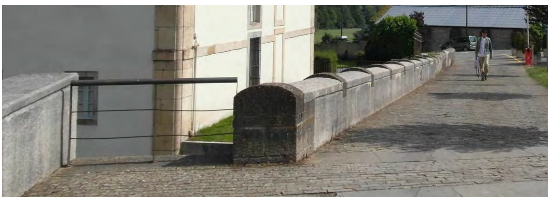
Fotografías en las que se distingue el tramo de muro de contención consolidado con hormigón
