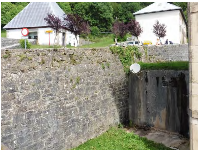
Izda., sección del tramo meridional del muro de contención obtenida mediante la medición con escáner láser. Dcha., fotografía del estado actual en la que se ve la factura de peor calidad de la coronación
