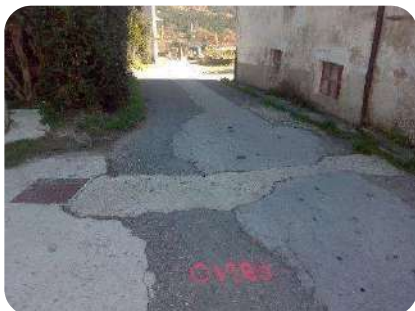
Foto 16. Pk0+180. Tramo fachada nº74 (MD)
