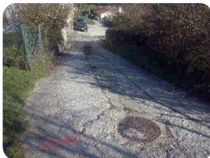
Foto 2. Pk0+040 (avance). nº64ª a nº60
