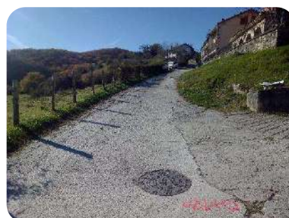
Foto 9. Pk0+120 (retroceso). Final iglesia
