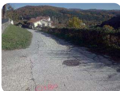
Foto 8. Pk0+080. Inicio tramo iglesia (MI)
