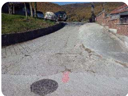
Foto 10. Pk0+120. Calle a iglesia y nº54/52
