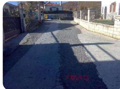
Foto 15. Pk0+180 (retroceso) final nº29
