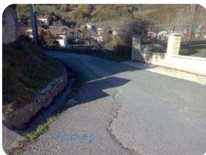
Foto 29. Pk1+070 (retroceso) final subida
