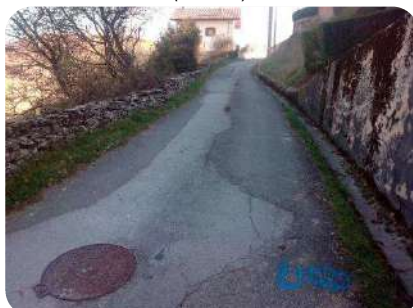
Foto 11. Pk1+020. Muro bajada nº52 (MD)
