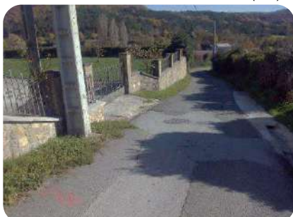
Foto 10. Pk0+240 (avance) fachada nº35
