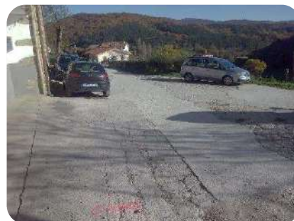
Foto 6. Pk0+060. (avance). Fachada nº60
