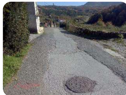
Foto 18. Pk0+200. (avance) Tramo nº74/nº33
