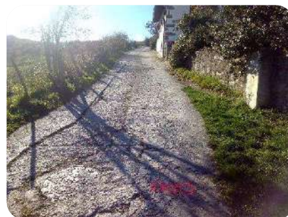
Foto 3. Pk0+040 (retroceso). nº64ª a nº60
