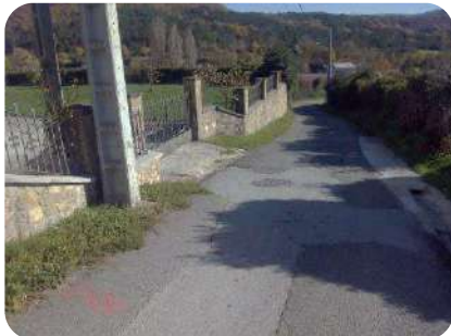
Foto 22. Pk0+240 (avance) fachada nº35
