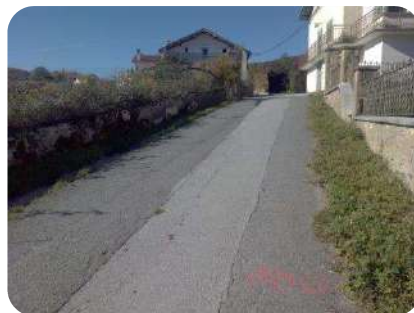
Foto 21. Pk0+240 (retroceso) fachada nº35
