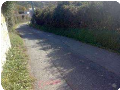
Foto 23. Pk0+260. Final fachada nº35 (MI)
