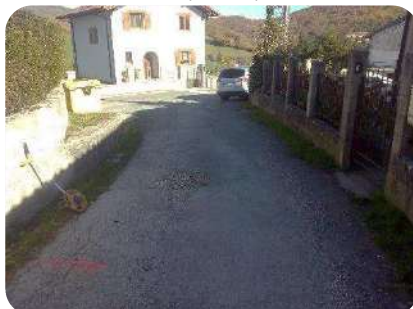
Foto 5. Pk0+140 Llegada "Y" calles nº29/nº72
