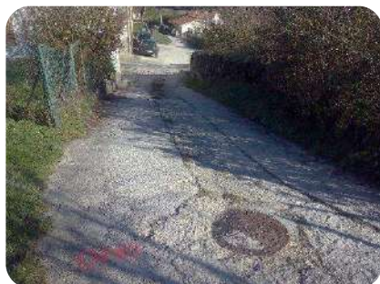
Foto 4. Pk0+040 (avance). nº64ª a nº60
