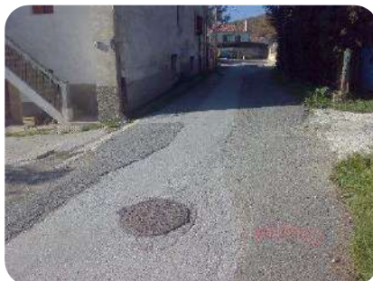
Foto 17. Pk0+200. (retroceso) Final nº74
