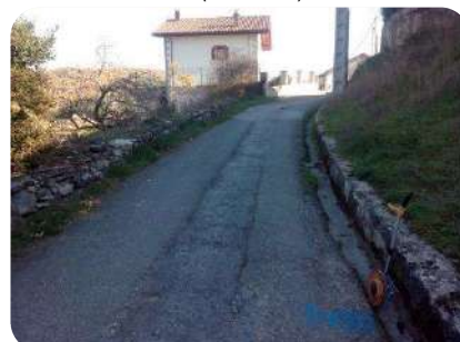
Foto 12. Pk1+040 Tramo entre muretes
