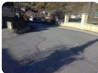
Foto 30. Pk1+075 "Y" calles nº29/nº72/nº70
