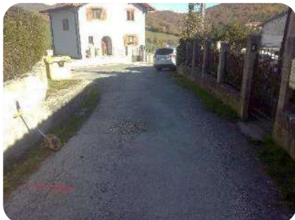
Foto 13. Pk0+140 Llegada "Y" calles nº29/nº72
