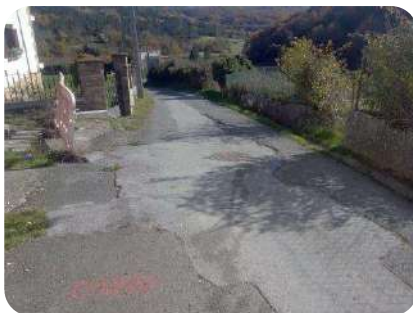
Foto 20. Pk0+220 Tramo nº33 (MI) a nº35 (MI)
