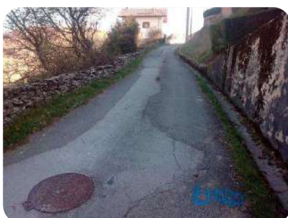
Foto 26. Pk1+020. Muro bajada nº52 (MD)
