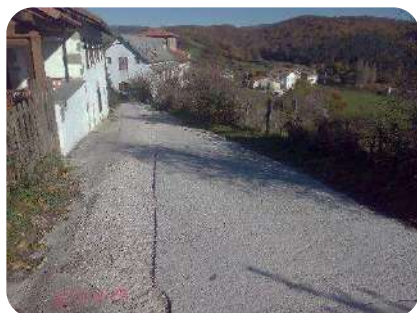
Foto 1. Pk0+000 Inicio previo a nº35
