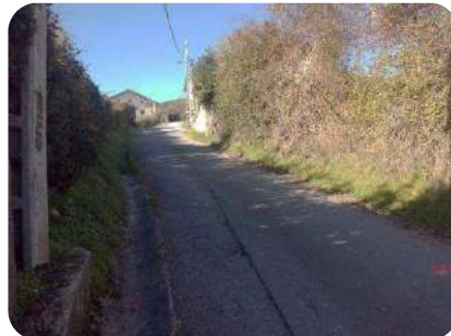
Foto 24. Pk0+280 (retroceso), final actuación
