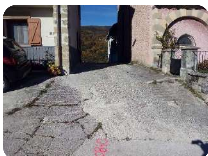
Foto 7. Pk0+080. Entronque a calle nº56
