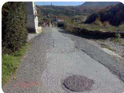
Foto 8. Pk0+200. (avance) Tramo nº74/nº33
