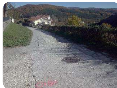
Foto 3. Pk0+080. Inicio tramo iglesia (MI)
