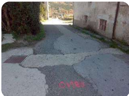
Foto 7. Pk0+180. Tramo fachada nº74 (MD)
