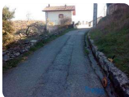
Foto 27. Pk1+040 Tramo entre muretes
