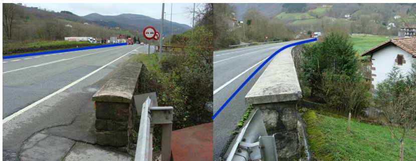
Trazado de microzanja por arcén de margen izquierda sentido Behobia de N-121A en tramo A proyectado.
