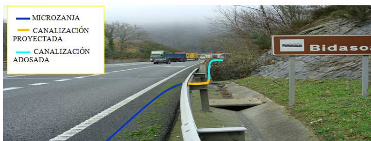
Trazado de microzanja por arcén de margen derecha previo a VIADUCTO 04, en tramo B proyectado.
