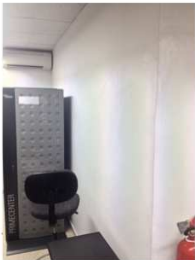
Fig. 5 - Tabique a demoler
