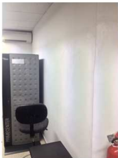
Fig. 5 - Tabique a demoler
